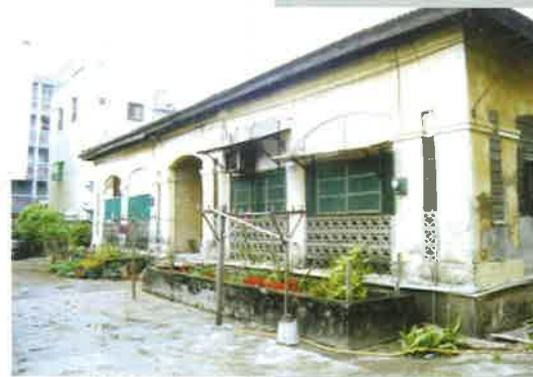
圖 2-8 前高雄州水產試驗所，建築物的東、西、南三面有弧形拱圈迴廊設計。
