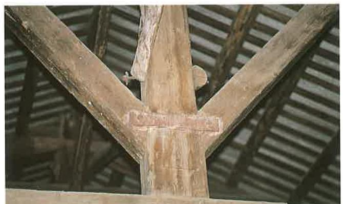
C棟木桁架節點細部，可見鐵件加固。
