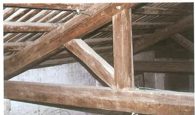
C棟木桁架有抗張力鐵筋。
