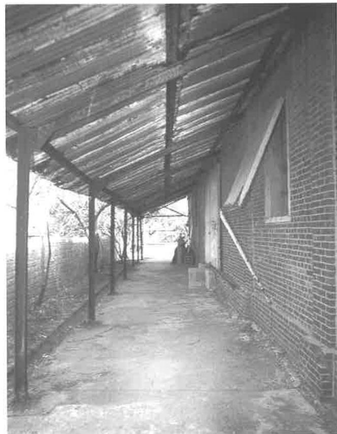
D棟北面棚架，與C棟棚架的構造類似，但缺少拉桿鐵件。
