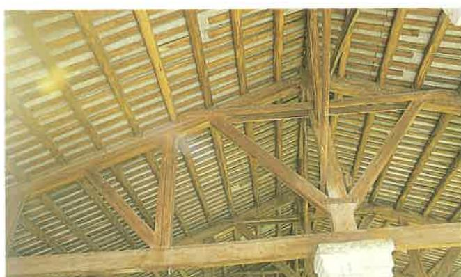
C棟木桁架用中柱式。
