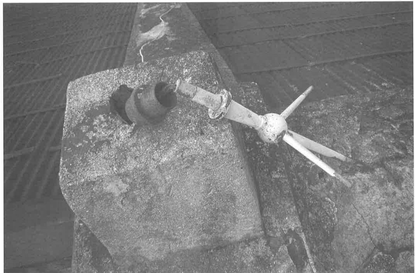
B棟屋頂避雷針，基座已銹蝕損壞。
