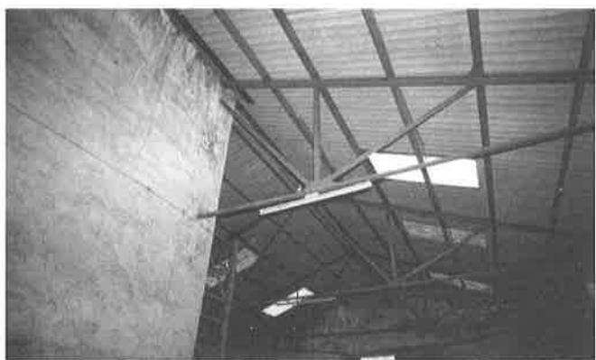
D棟中央兩組鐵桁架皆由室內隔間牆體中伸出。
