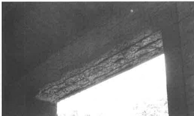
門楣混凝土脫落、露出鋼筋。
