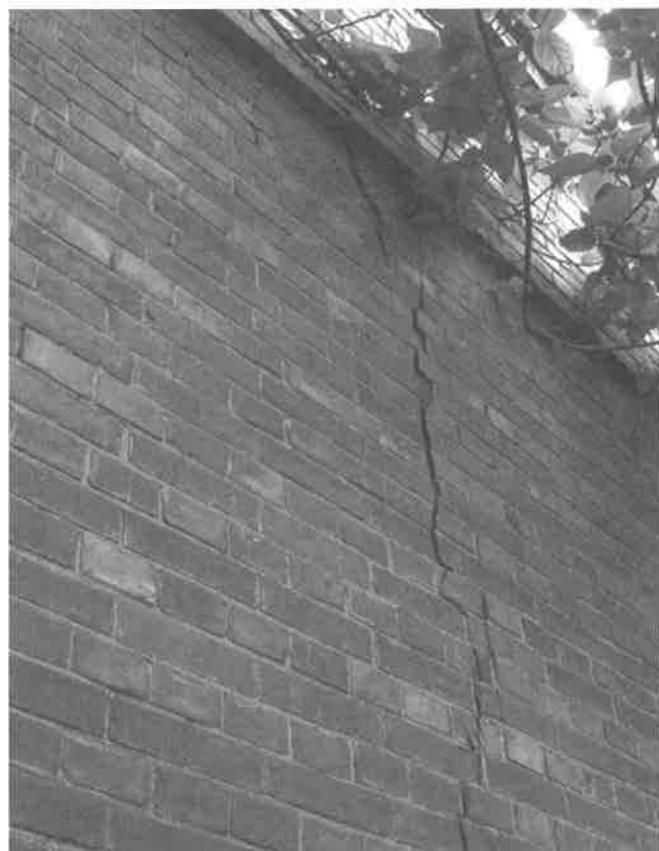
西面磚牆面因地震產生裂痕。
