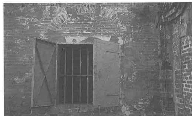
北面窗外再裝設鐵窗。壁面灰泥斑駁脫落，露出以紅磚砌的牆面。
