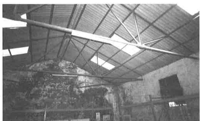
D棟內部無附壁柱，鐵桁架直接跨在承重磚牆上，自牆體伸出，跨距11.4公尺。
