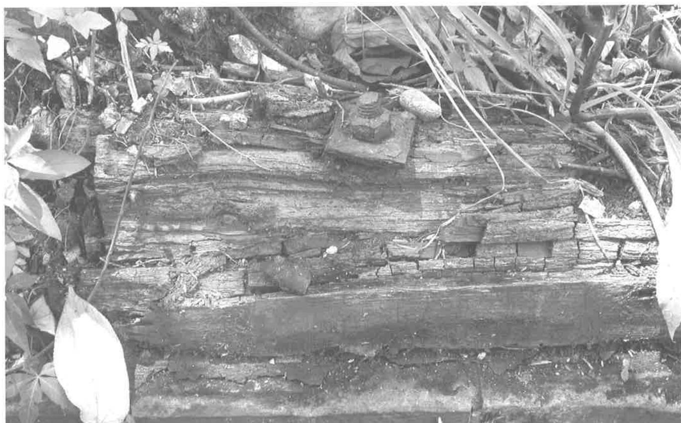
台基頂端設有木質地樑，並以螺栓鐵件加固。
