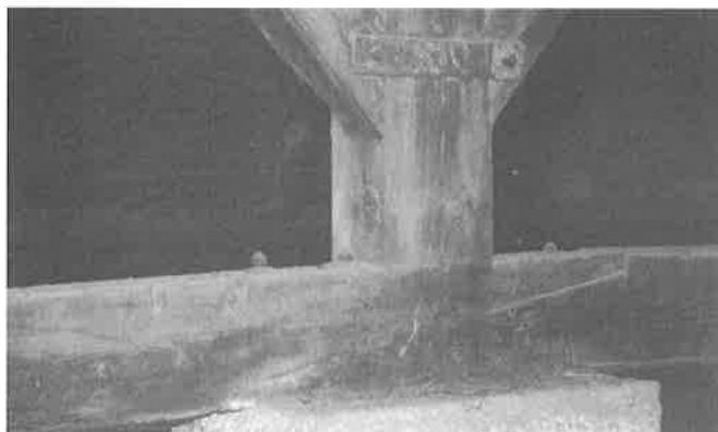
屋架下弦在中央對接，並使用螺栓加固，豎杆與斜桿交接處也有緊結鐵件。
