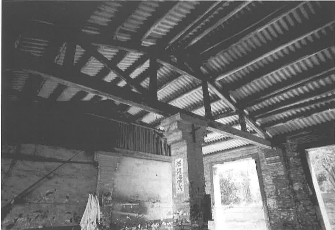
A棟屋頂採用西式木屋架，中央設磚柱。
