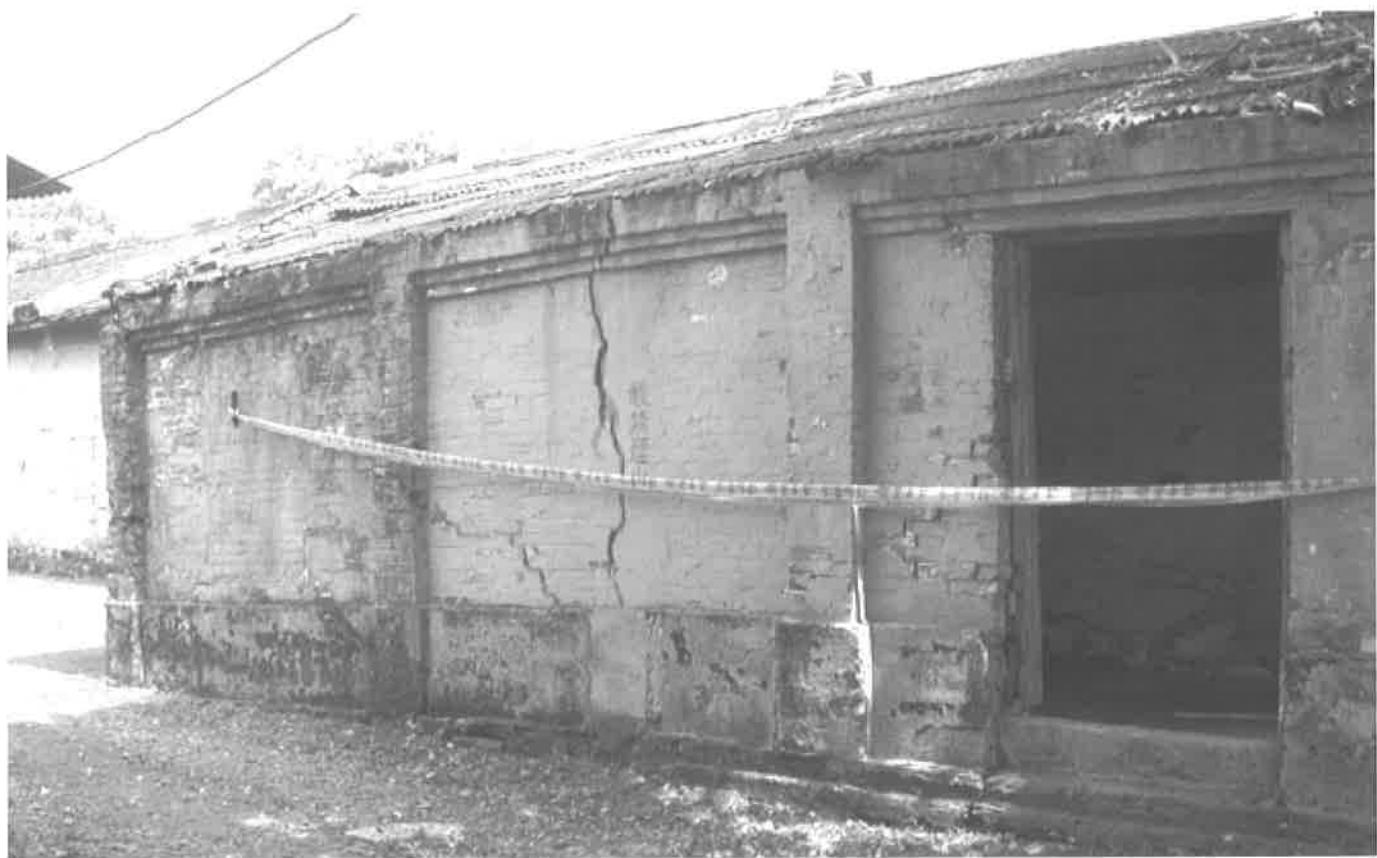
E棟受地震破壞而從中斷裂。
