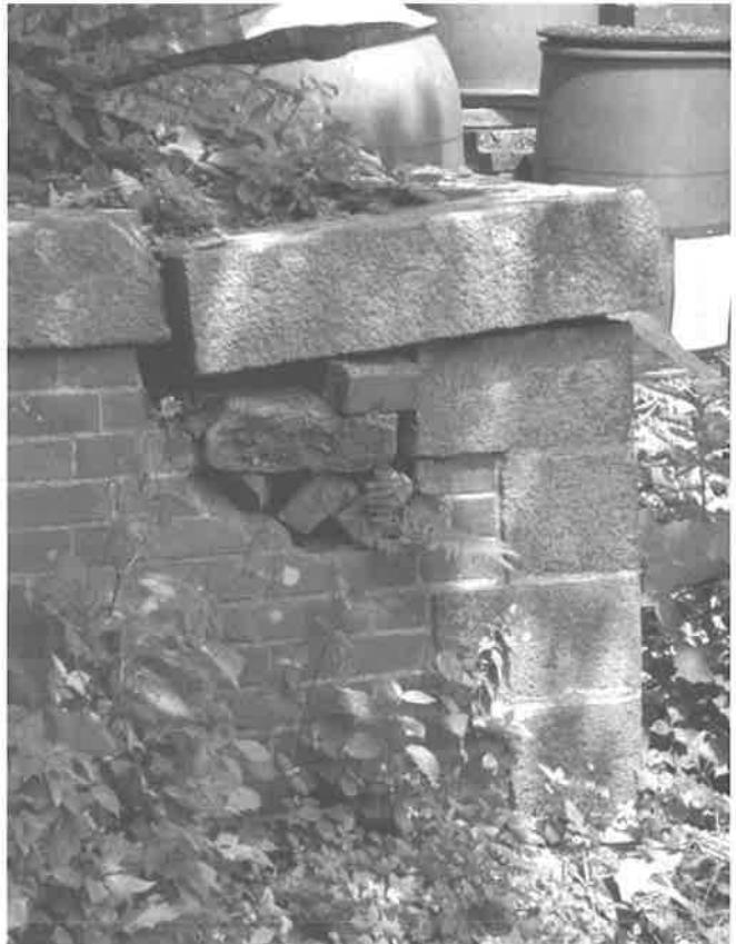
月台磚牆崩落損壞情況。
