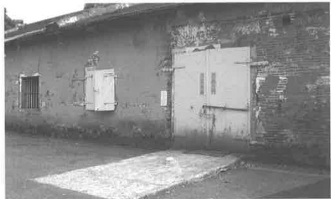
B棟北面目前的地坪比新建時高，所以建築基座已埋沒在地坪之下。
