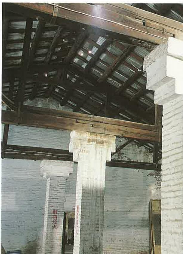
B棟倉庫內部，磚柱頂擴大並置石板承桁架重量。
