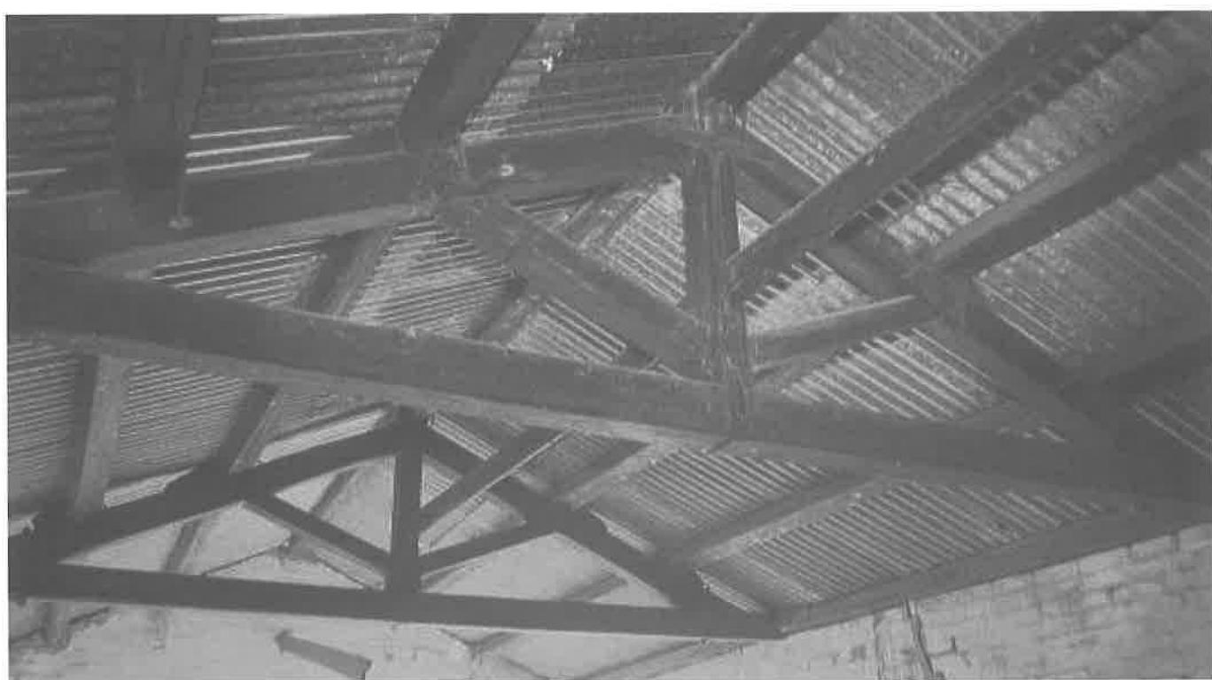
E棟屋架跨距4.1公尺，並使用鐵件加固。屋面前以浪板覆蓋。
