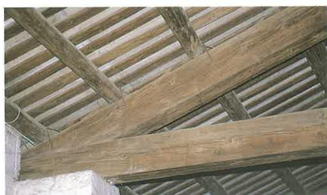
C棟桁架兩端架在柱頭石板上。
