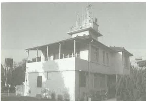
現存的臺中測候所為光復後修建，風力塔亦為R.C.構造。
