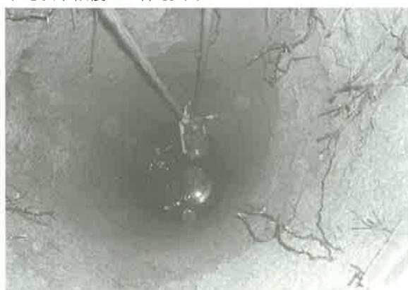
植物根莖已穿越磚壁縫隙，在內部蔓延。
