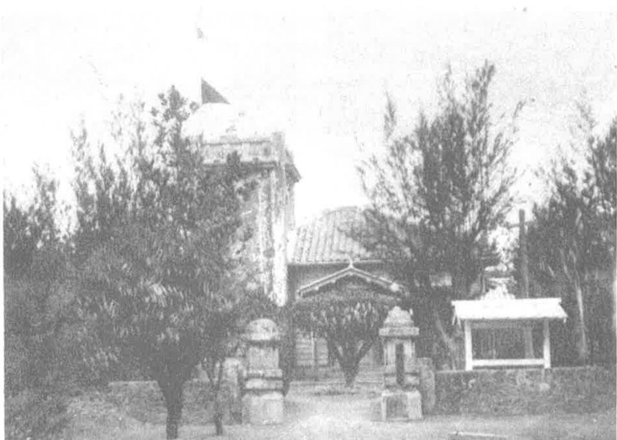
恆春測候所，格局與臺東測候所類似，但風力塔為鋼筋混凝土構造。資料來源：勝山寫真館《臺灣紹介最新寫真集》，1931年，頁95。
