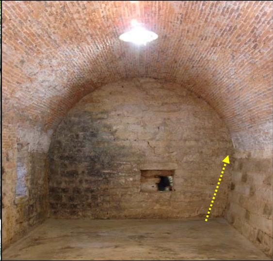
北向甬道靠外側石砌牆明顯有斜度。(如圖中箭頭所示)
