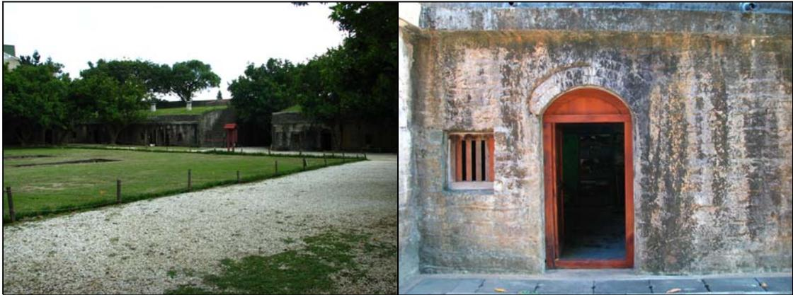
中庭走道鋪設白石級配，可以部分鋪平面石板。室內、室外間的門檻宜加裝活動式斜坡。
