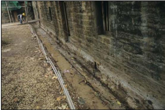
整修時內埋排水溝情形。
