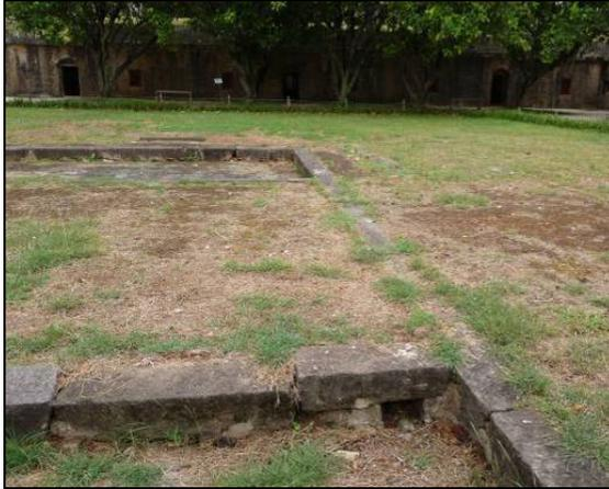
兵署中軸通道兩端留有排水孔洞，以利排水。
