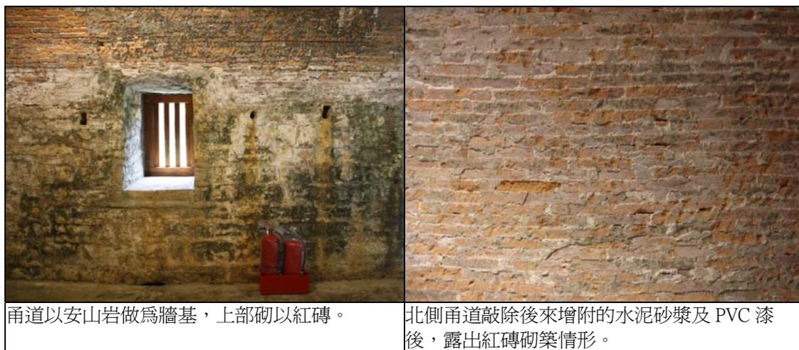
四邊甬道的構造略有差異，值得討論，東邊、東南邊與西南邊的石牆基大體上爲垂直於地面之砌法，但西邊與北邊的石牆卻有一面具有斜度，靠外側的石砌也許爲了抵抗巨大的覆土橫壓力，故意砌出斜度。石砌下方是否採用放腳作法？由於未經破壞挖掘，無法得知，如據清末其他遺物推測，可能亦採放腳基礎作法。
