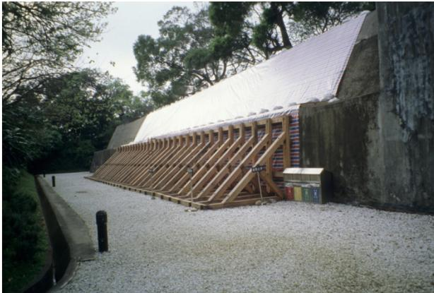
南向正門旁子牆受損，目前暫時性補強措施。
