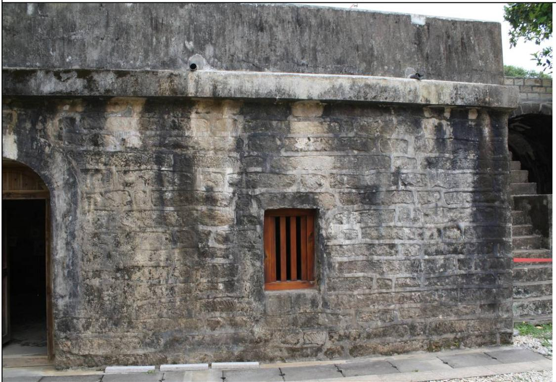
現今在回濺嚴重的牆體下設置石條，讓從排水管中洩下的水可以有個緩衝。
