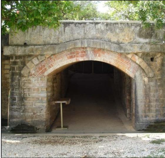
甬道入口上的拱圈以四皮紅磚砌築。
