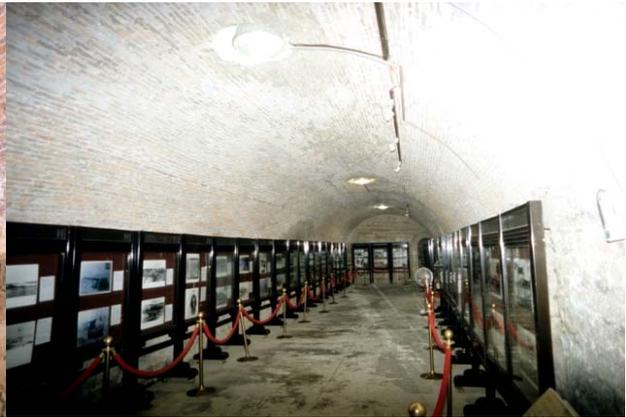
甬道拱圈砌磚，靠外側下方(圖右)石造牆體明顯打斜。甬道內部的文化展示主題館。
