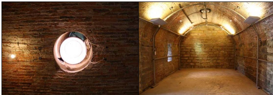
前期工程所設計的燈具，因置於甬道通風管下，使得空氣流通略有窒礙。原貌展示的展示空間裡的鋼管支架。
