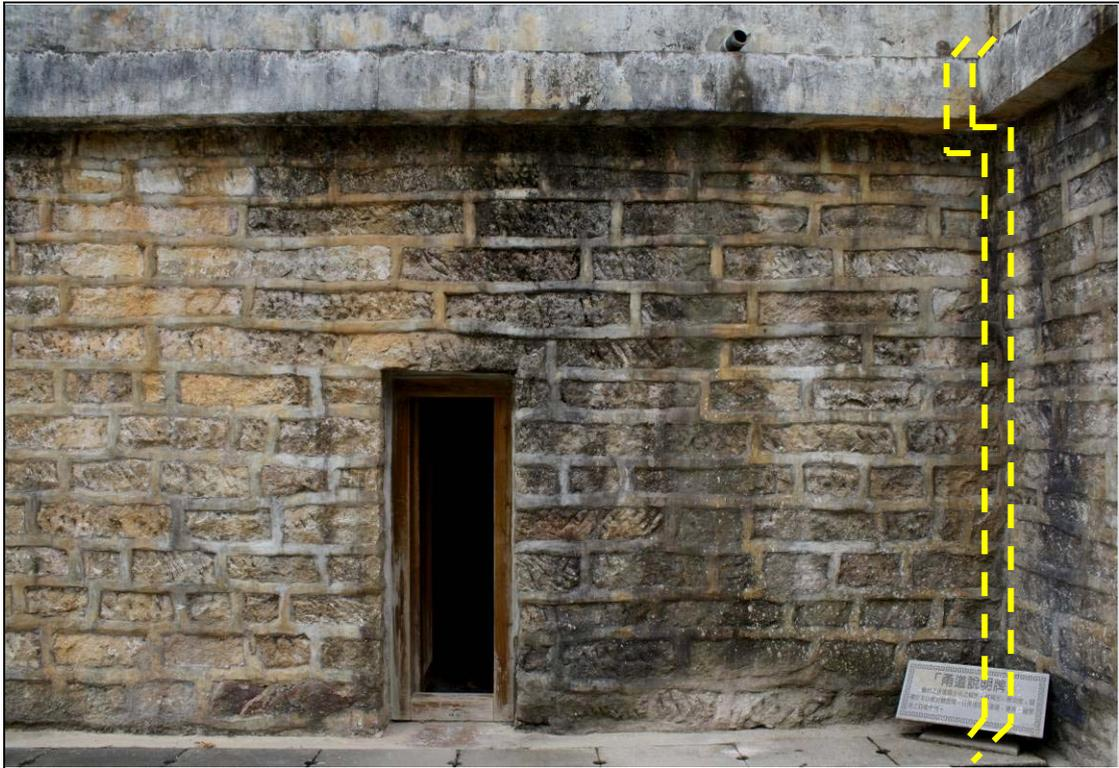
建議可在角落增設排水管，將單一排水管線集中到排水溝道，讓排水溝的水從角落的排水管洩下。
