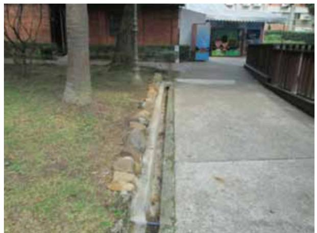
【圖9】領事官邸東側排水溝受土推擠壓變形復原後
