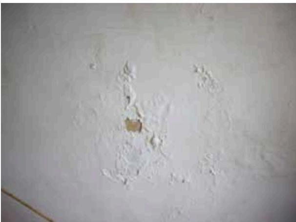
【圖25】紅毛城室內牆面局部粉刷層剝落及有水漬痕跡
