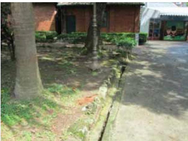
【圖8】領事官邸東側排水溝受土推擠壓變形復原前
