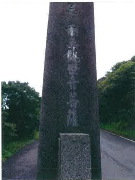
圖 79 柱子題刻被噴漆破壞（一）
