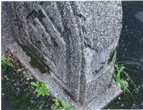
圖 77 夾杆石表面洗石子剝落
