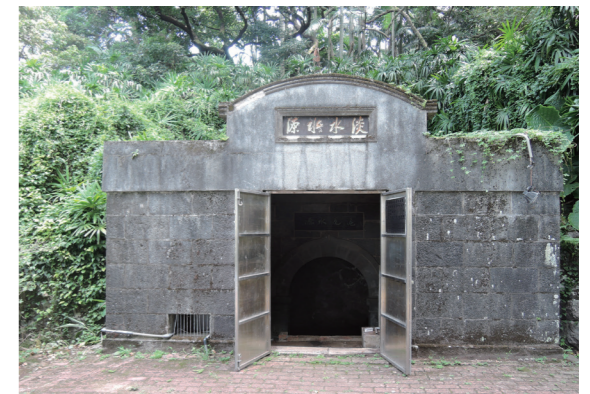
「滬尾水道」是臺灣第一個自來水設施
