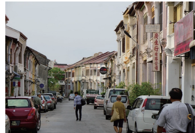
Lebu Cannon（大砲路），僅在街道立面上進行粉刷，尚未進行修復。
