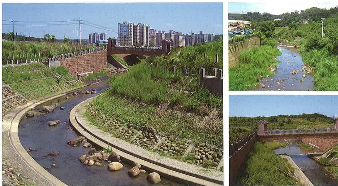
1 2 3 1 整治後的公司田溪 2 商工橋前的公司田溪 3 公司田溪橋
