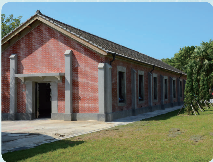
淡水海關碼頭內的倉庫， 牆面使用清水紅磚，採 一順一丁的平英砌法。 (謝旺霖提供)
