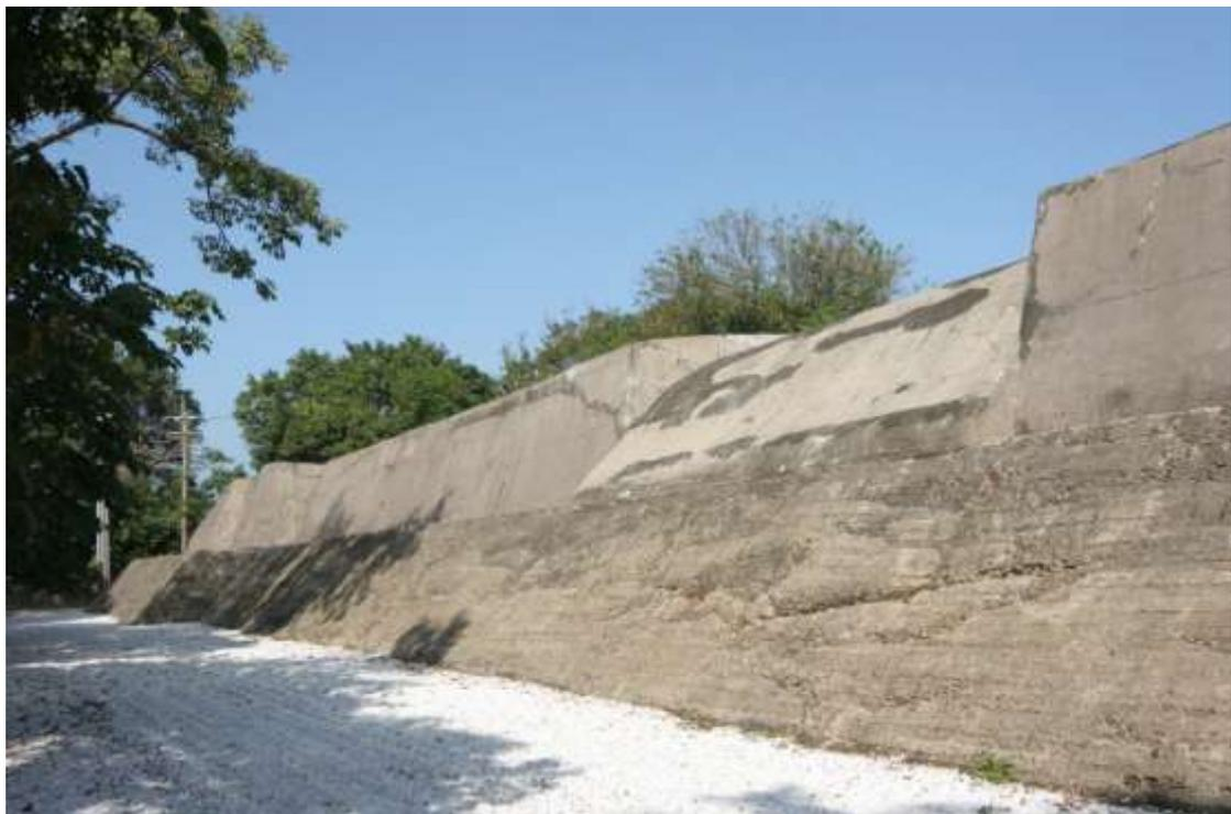
圖 2-03 由鐵水泥建造的牆垣、壕溝及礮門
