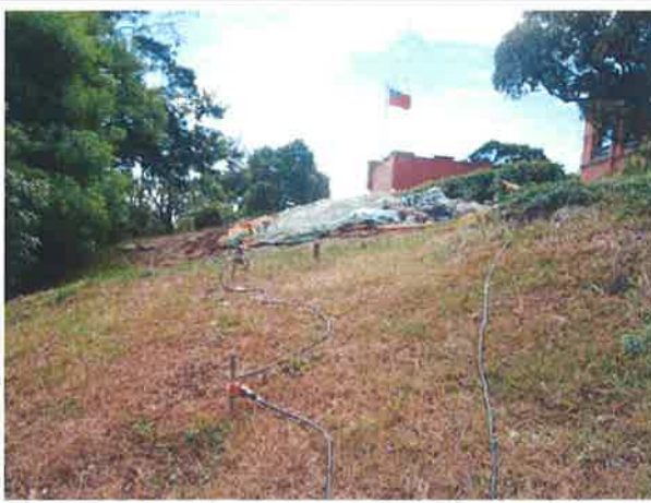
圖 B-12 三維地電阻影像剖面探測 現場施測-4
