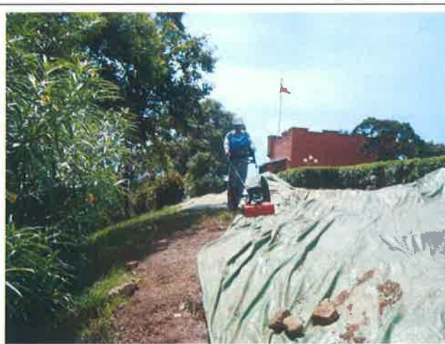
圖 B-2 透地雷達現場施測-2
