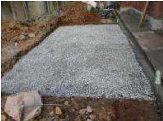
照片 6-61 花崗石軟鋪地坪鋪設範圍開挖整地及碎石級配鋪設
