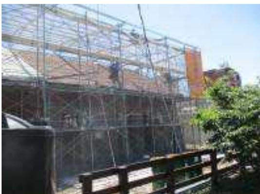
照片 4-39 人字型鋼架與施工架間斜撐安裝固定
