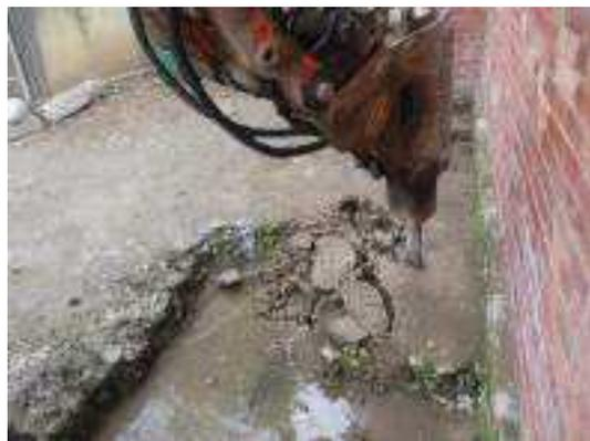
照片 5-26 北側犬走及排水溝填平或墊高處以小型怪手打鑿
