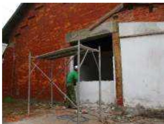
照片 4-46 古蹟建築北側門洞遭砌磚封填以手持式打鑿機打除
