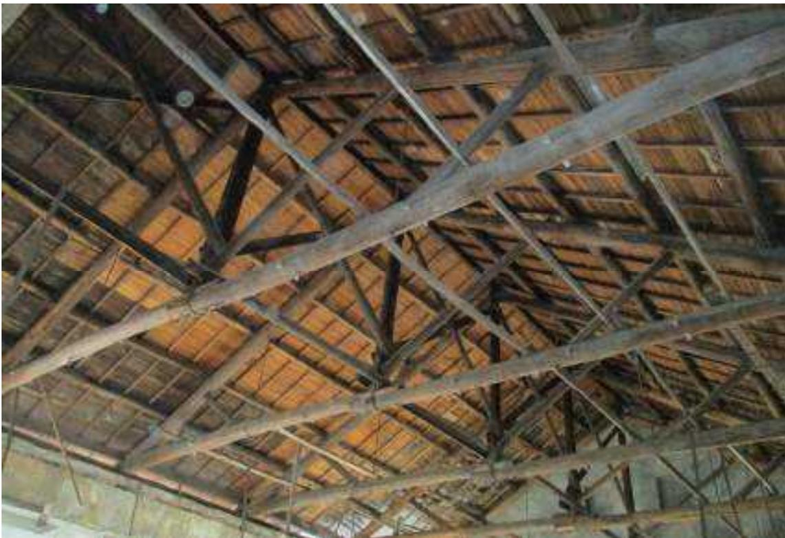
照片 8-11 「滬尾小學校禮堂」室內採用6組大跨距西式中同柱式桁架系統
