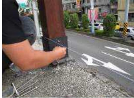
照片 6-76 木製欄杆木柱安裝固定
