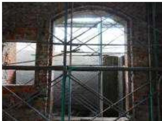
照片 4-48 外牆體窗洞遭砌磚封填以手持式打鑿機打除完成
