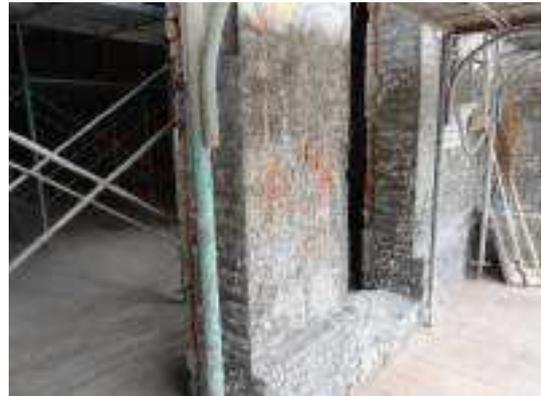
照片 4-76 外牆表面磁磚鑿除完成
