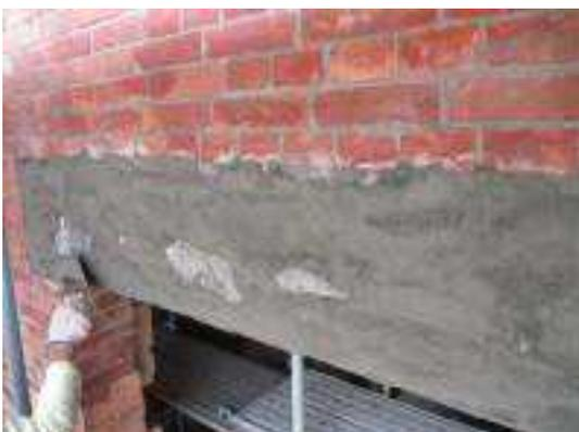
照片 5-169 門楣鋼筋植筋處以修補型無收縮水泥填補
