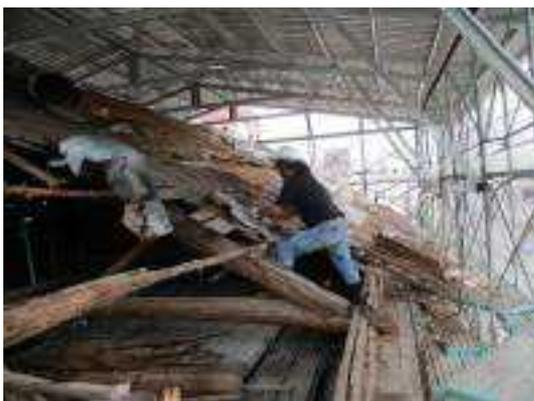
照片 4-59 野地板上鐵皮拆除
