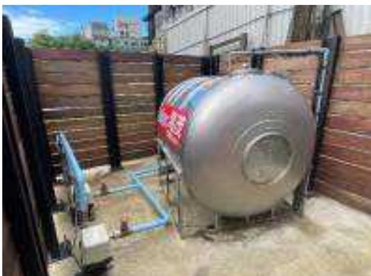
照片 6-149 不銹鋼水塔及泵浦安裝完成
