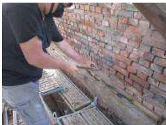
照片 5-76 屋架木構件龜裂處木片填補後修整
