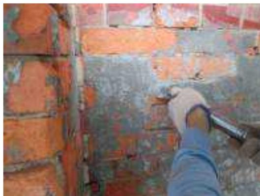
照片 8-6 清水磚砌外牆磚料表面水泥漿黏結料鑿除
