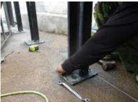
照片 6-81 木格柵鋼柱安裝固定
