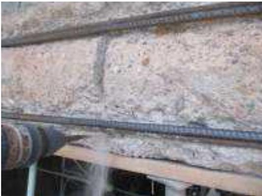
照片 5-165 門楣箍筋植筋處打鑿及鑽孔
