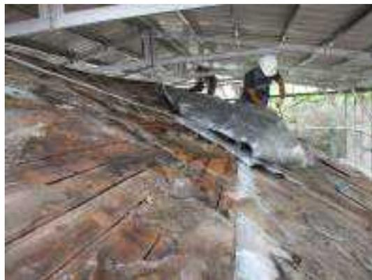
照片 4-58 野地板上鐵皮拆除
