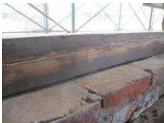
照片 5-112 敷桁龜裂處木片修補完成
