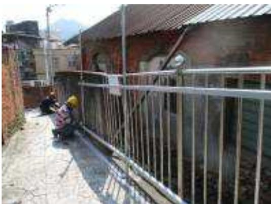
照片 4-7 建築基地東側施工圍籬骨架安裝
