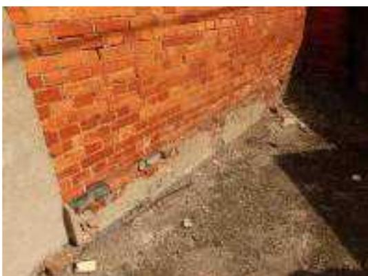
照片 2-48 滬尾小學校禮堂南側既有清水磚砌牆體磚料間灰縫及牆基表面水泥砂漿粉刷風化剝落
