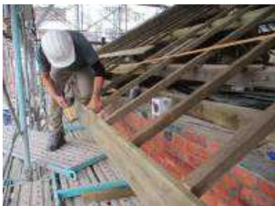
照片 5-135 破風板以不銹鋼釘裝釘固定
