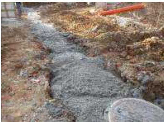
照片 6-147 污水銜接衛生下水道排水管開挖路徑CLSM (控制性低強度回填材) 回填
