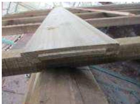
照片 5-134 破風板板料相接處樺頭（公樺）加工
