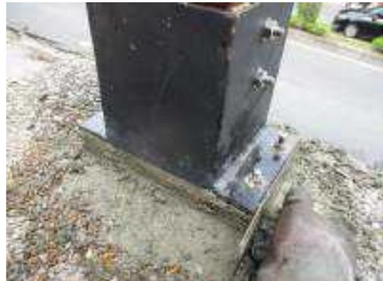
照片 6-78 木製欄杆鋼製基礎座底部水泥砂漿填補
