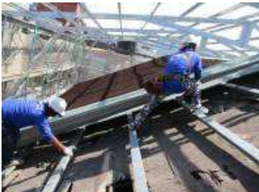
照片 4-53 後期鋪設鋼浪板屋面拆除
