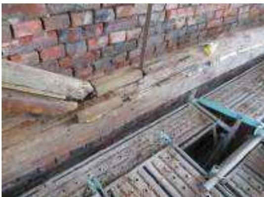
照片 5-79 屋架木構件腐朽處以木塊修補
