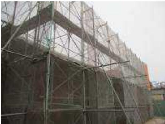
照片 4-21 外部施工架搭設完成
