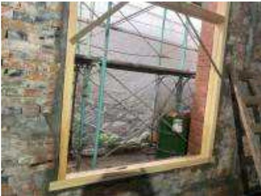
照片 5-181 木窗框與磚牆間防水砂漿填塞
