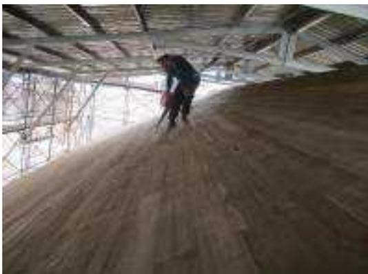
照片 6-1 屋面防水毯鋪設前以風機將野地板上粉塵吹淨
