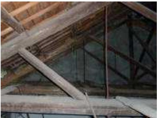
照片 2-58 由南至北第3組木屋架螞蝗釘及螺栓吊桿銹化
