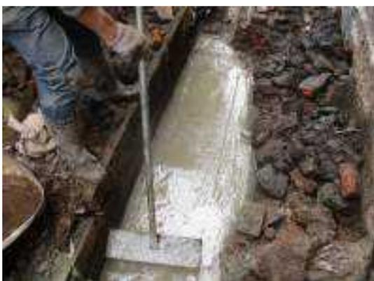
照片 5-29 排水溝重作處溝底140kg/cm<sup>2</sup>混凝土打築
