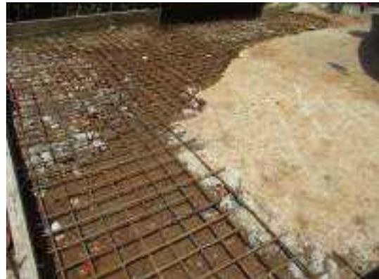
照片 6-62 花崗石硬鋪地坪整地及鋼筋綁紮
