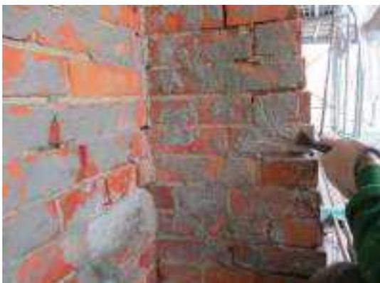
照片 8-5 清水磚砌扶壁柱磚料表面水泥漿黏結料鑿除
