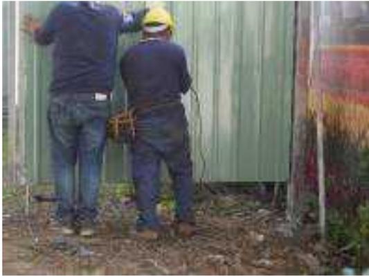
照片 4-9 施工圍籬鋼浪板料安裝
