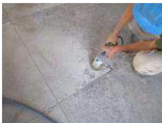
照片 5-6 抹石子地坪表面泥漿無法以氣動式平頭鑿子鑿除處改以打磨機磨除
