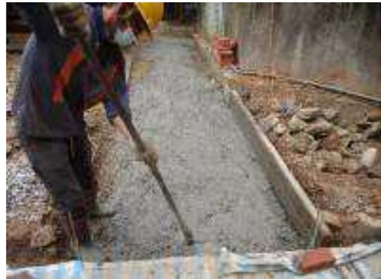
照片 6-70 混凝土步道140kg/cm<sup>2</sup>混凝土打底
