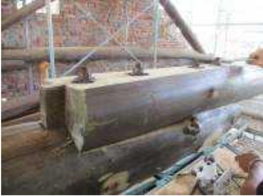
照片 5-81 陸樑安裝組立及投掛處鐵件安裝調整
