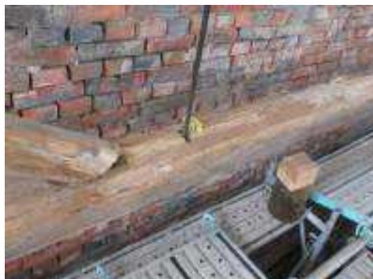
照片 5-80 屋架木構件腐朽處以木塊修補完成
