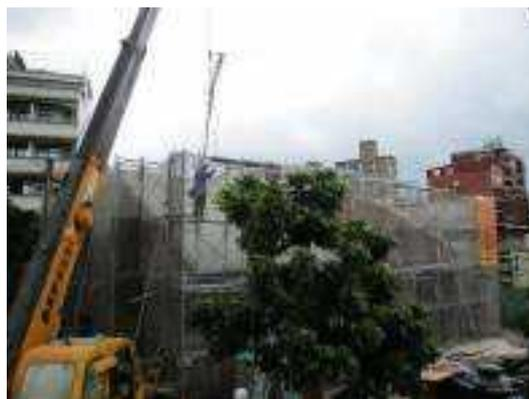
照片 4-38 人字型鋼架吊裝於施工架上
