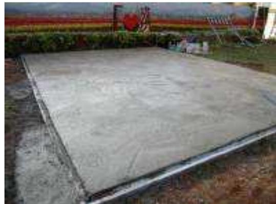
照片 4-28 工務所210 kgf/cm<sup>2</sup>混凝土打築
