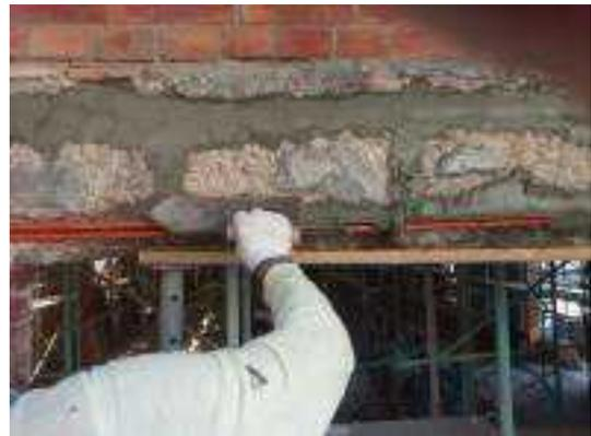
照片 5-168 門楣鋼筋植筋處以修補型無收縮水泥填補
