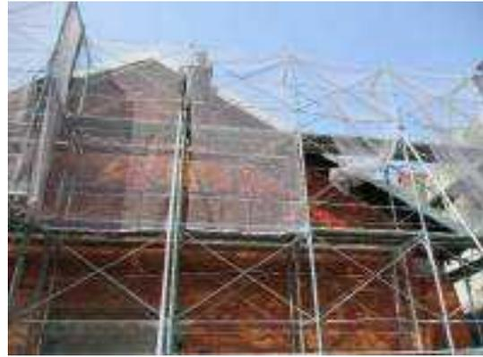
照片 4-20 外部施工架搭設完成後防塵網安裝
