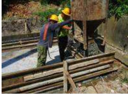
照片 6-14 服務空間地梁210kg/cm<sup>2</sup>混凝土打築
