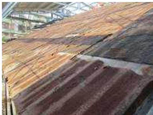
照片 4-56 後期鋪設鋼浪板屋面拆除後
