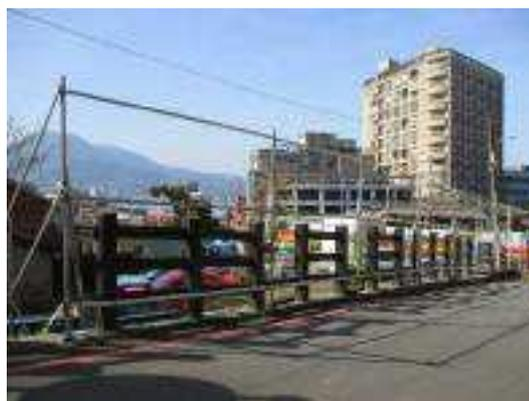
照片 4-8 建築基地北側施工圍籬骨架安裝
