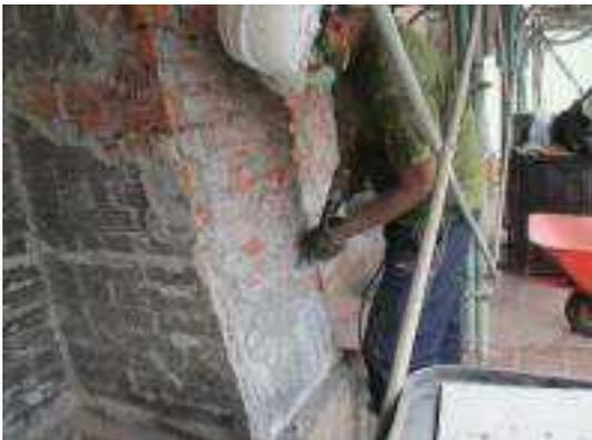
照片 4-77 外牆表面磁磚水泥黏結料鑿除
