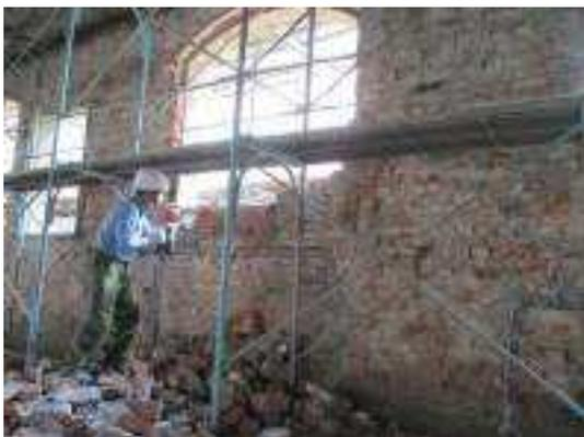
照片 4-47 外牆體窗洞遭砌磚封填以手持式打鑿機打除
