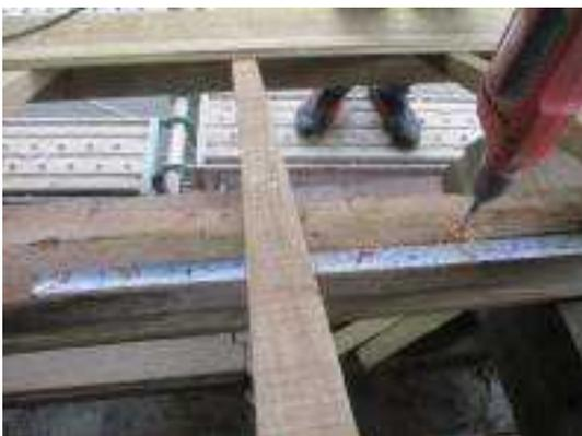
照片 6-109 舊木構件灌注位置放樣及鑽孔
