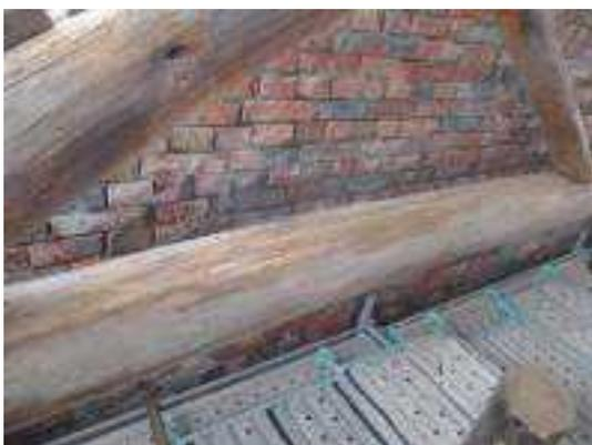
照片 5-77 屋架木構件龜裂處以木片填補完成
