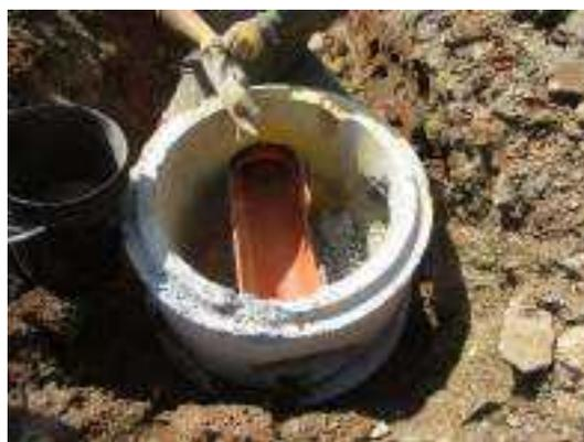
照片 6-146 陰井埋設及污水管銜接
