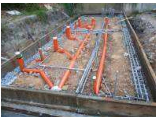
照片 6-143 污排水及給水管佈設完成
