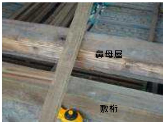
照片 7-8 鼻母屋與敷桁有約10至12公分左右空隙
