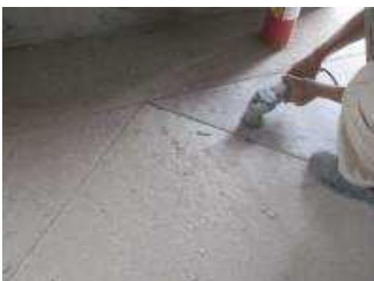
照片 5-5 抹石子地坪表面泥漿無法以氣動式平頭鑿子鑿除處改以打磨機磨除
