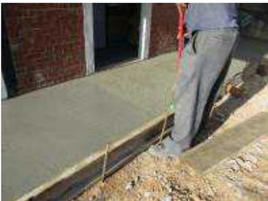
照片 6-73 混凝土步道表面掃毛處理
