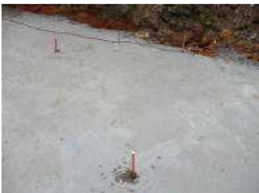
照片 6-119 電力接地銅棒埋設
