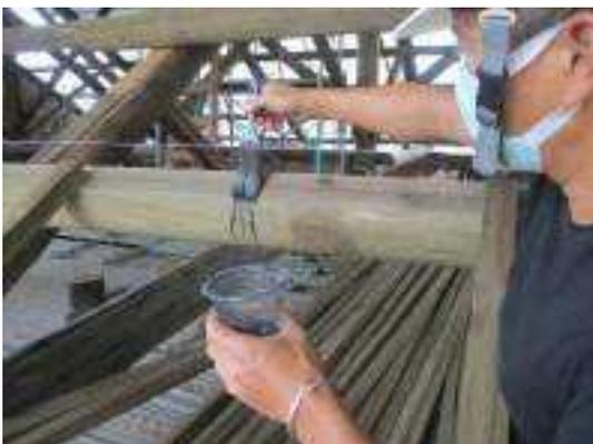
照片 5-127 母屋與檼木相接處榫洞開鑿後防腐刷塗處理
