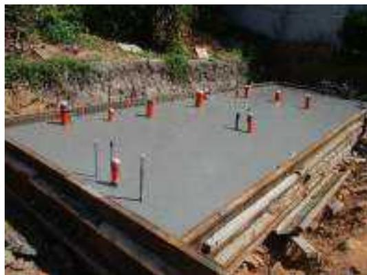
照片 6-22 服務空間樓板210kgf/cm<sup>2</sup>混凝土打築完成
