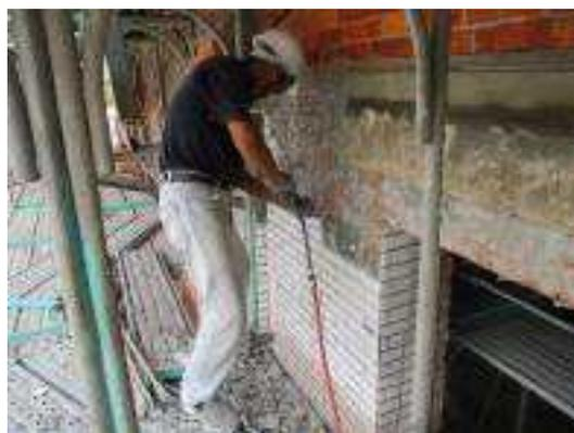
照片 8-4 清水磚砌外牆磚料表面貼覆磁磚鑿除
