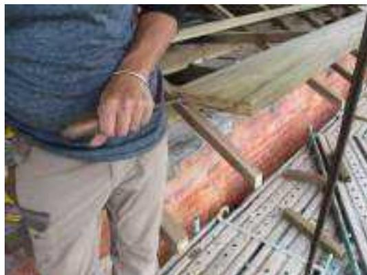
照片 5-132 破風板為增加板料相接密合度樺頭開鑿處理
