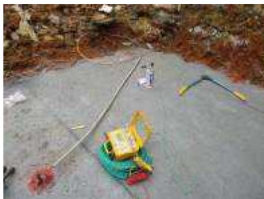
照片 6-120 電力接地施作及測試
