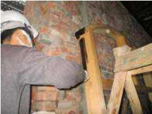
照片 8-21 木窗框與牆體接處面柏油刷塗增加防潮效果
