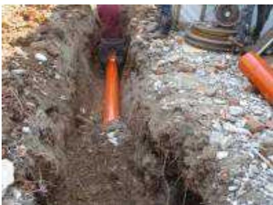
照片 6-145 污水銜接衛生下水道排水管佈設及回填
