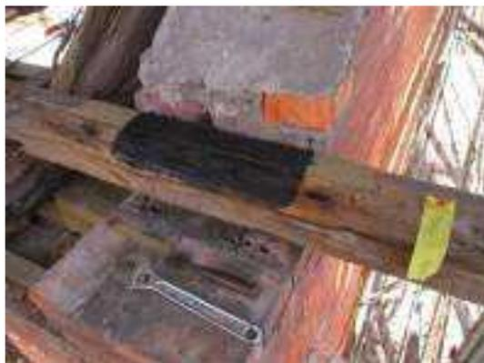
照片 5-116 鼻母屋腐朽處以木塊填補
