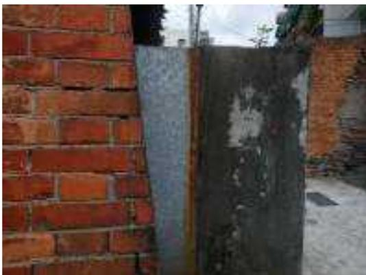
照片 2-50 滬尾小學校禮堂東側既有清水磚砌扶壁柱磚料間灰縫風化及剝落
