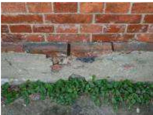
照片 2-9 滬尾小學校禮堂放腳式基礎採紅磚砌造露出地面部分以水泥砂漿粉刷
