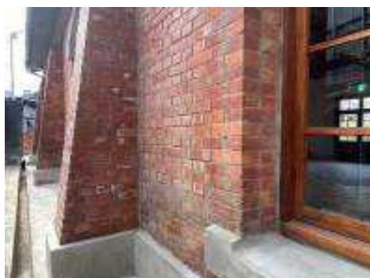
照片 5-52 東側外牆由南至北第三跨間清水磚砌牆補砌及扶壁柱砌作完成
