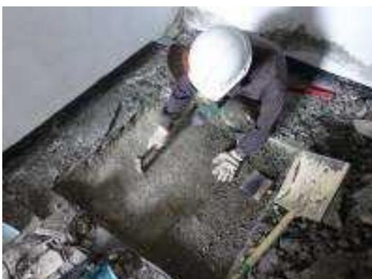
照片 4-83 初建時抹石子地坪表面泥漿以鐵鎚鑿除
