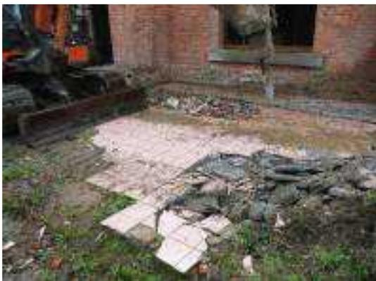
照片 5-25 西側犬走及排水溝填平或墊高處以小型怪手打鑿
