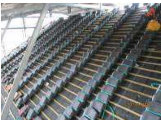
照片 5-147 瓦料吊運至屋面鋪設點
