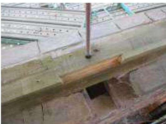
照片 7-5 敷桁安裝固定於磚砌牆頂
