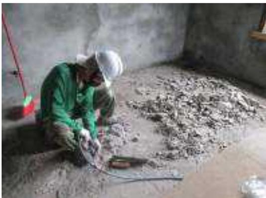
照片 5-3 抹石子地坪表面泥漿以氣動式平頭鑿子鑿除
