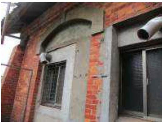
照片 8-17 東側由南至北第一跨間磚砌弧拱木窗，弧拱表面以水泥砂漿粉刷並施作拱心石（keystone）造型
