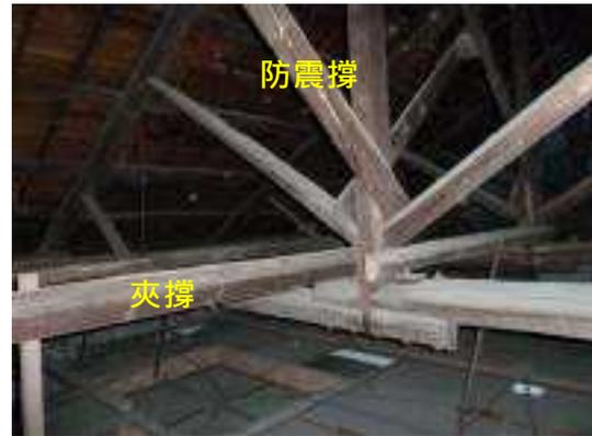
照片 2-14 滬尾小學校禮堂西式中柱式屋架系統為防止傾倒及位移以防震撐及夾撐固定
