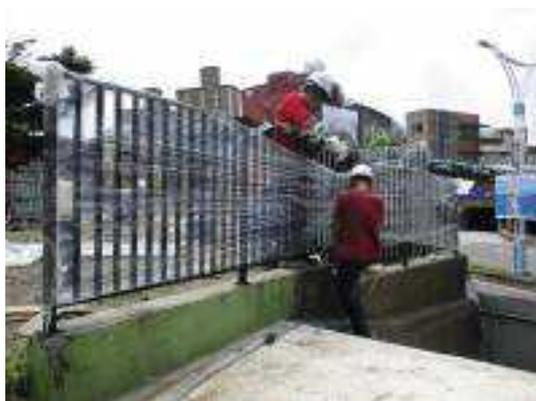
照片 6-89 下層平臺鐵製欄杆安裝固定
