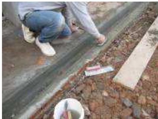
照片 5-32 北側排水溝表面1：3水泥砂漿粉刷
