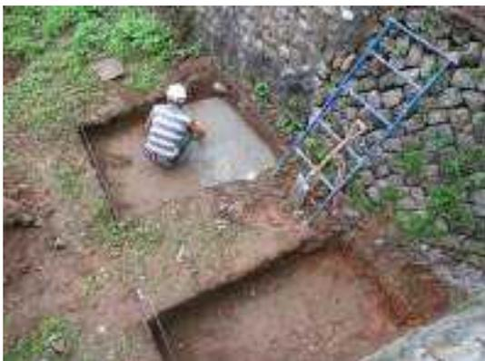
照片 6-53 鋼製樓梯基礎結構開挖及 140kg/cm<sup>2</sup>混凝土打底
