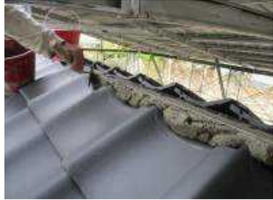
照片 5-150 大棟底部水泥砂漿施作
