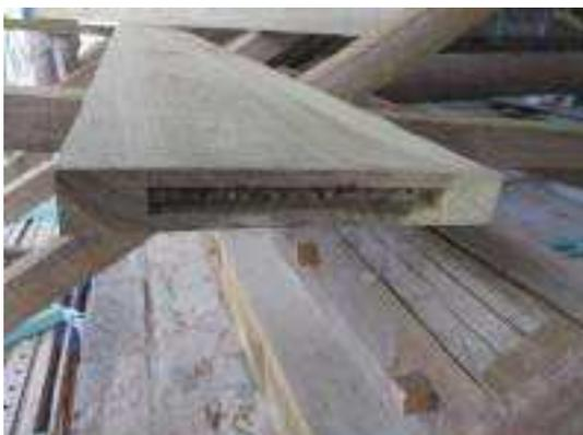
照片 5-133 破風板板料相接處樺頭（母樺）加工
