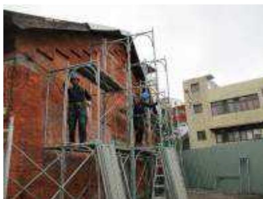
照片 4-18 外部施工架搭設
