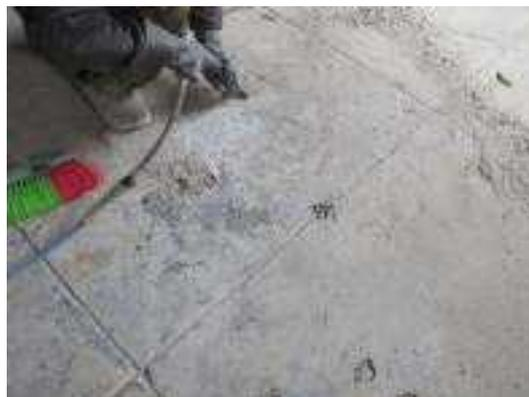
照片 5-4 抹石子地坪表面泥漿以氣動式平頭鑿子鑿除
