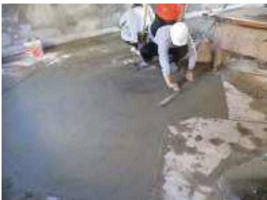
照片 5-11 抹石子重作範圍水泥砂漿壓鏝塗刷後以木尺刮平
