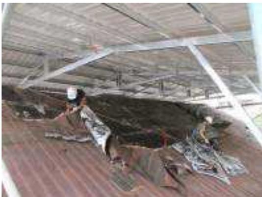
照片 4-57 野地板上鐵皮拆除
