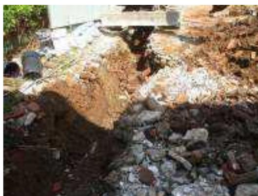
照片 6-144 污水銜接衛生下水道排水管依申請路徑及深度開挖
