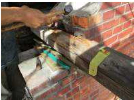
照片 5-115 鼻母屋腐朽處清除
