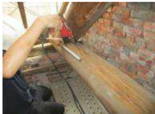
照片 6-110 舊木構件灌注位置放樣及鑽孔
