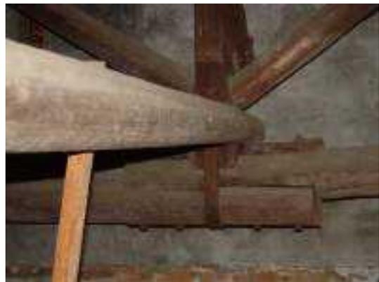
照片 2-59 由南至北第1組木屋架陸樑與中柱搭接固定之鞍型鐵片銹化
