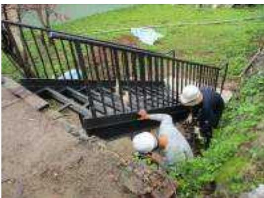
照片 6-57 鋼製樓梯鋼料結構安裝固定
