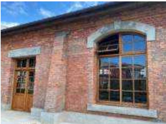
照片 8-23 東側牆上磚砌弧拱木窗搭配鋼筋混凝土平拱木門
