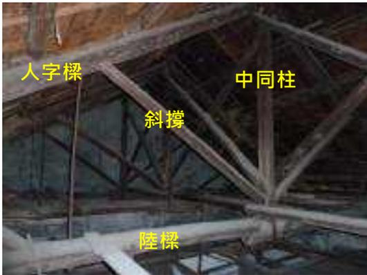
照片 2-13 滬尾小學校禮堂西式中柱式屋架系統 (king post truss)
