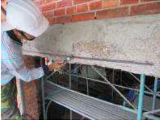
照片 5-163 門楣鋼筋銹蝕處以鐵刷刷除
