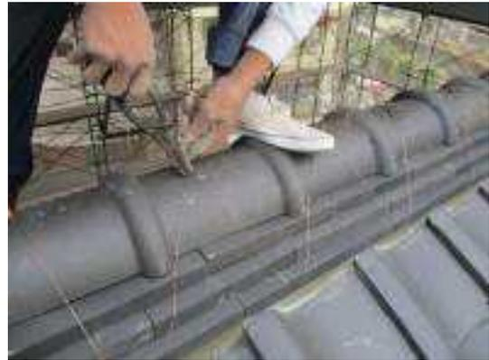
照片 5-152 大棟瓦鋪設並以銅線綁紮固定
