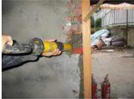
照片 5-180 木門框與磚牆間防水砂漿填塞
