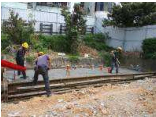
照片 6-21 服務空間樓板210kgf/cm<sup>2</sup>混凝土打築
