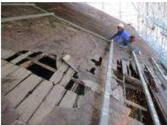
照片 4-55 後期鋪設鋼浪板下C型鋼拆除
