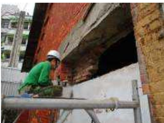
照片 4-45 古蹟建築北側門洞遭砌磚封填以手持式打鑿機打除
