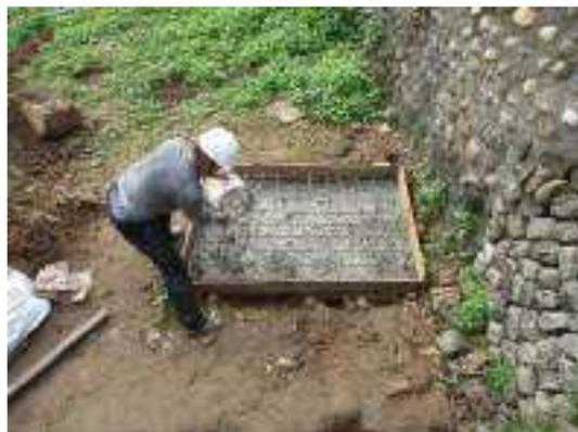
照片 6-54 鋼製樓梯基礎結構鋼筋綁紮及 210kg/cm<sup>2</sup>混凝土打築
