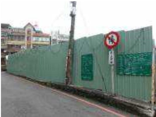
照片 4-11 建築基地北側施工圍籬搭設及安全警示燈安裝完成
