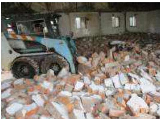
照片 4-51 古蹟建築內部磚砌隔間打除後磚料清除
