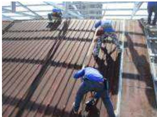
照片 4-54 後期鋪設鋼浪板屋面拆除
