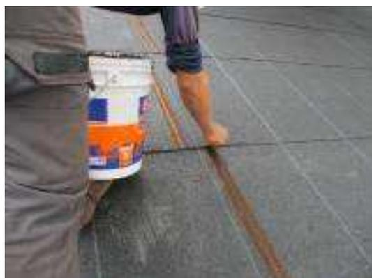
照片 6-6 礦石面防水毯搭接處以封口膠刷塗
