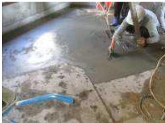
照片 5-10 抹石子重作範圍水泥砂漿壓鏝塗刷
