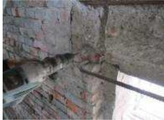
照片 5-164 門楣植筋處打鑿及鑽孔
