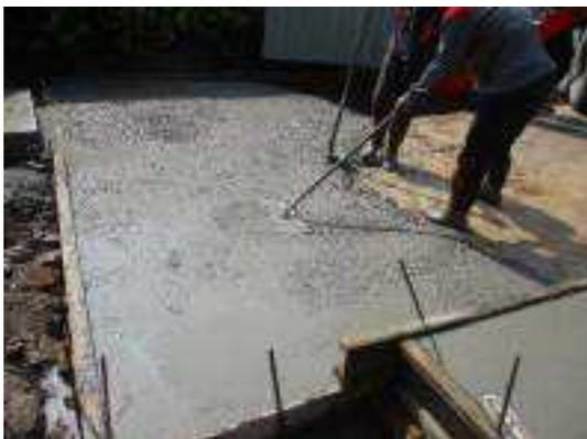
照片 6-63 花崗石硬鋪地坪210kgf/cm<sup>2</sup>混凝土打築
