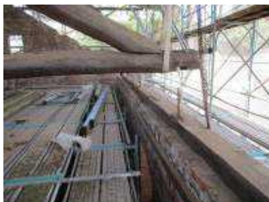
照片 7-6 屋架安裝固定於敷桁上
