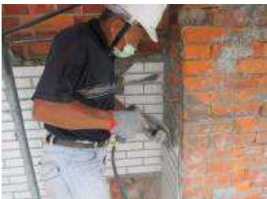
照片 8-3 清水磚砌扶壁柱磚料表面貼覆磁磚鑿除
