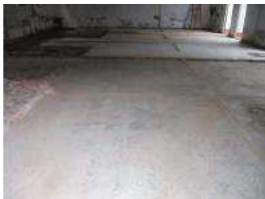
照片 4-52 古蹟建築內部磚砌隔間打除完成
