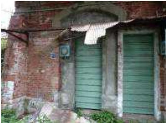
照片 2-66 滬尾小學校禮堂西側由南至北第3與第4扶壁柱間窗扇開口及牆體遭以砌磚封填或打除改為門扇開口
