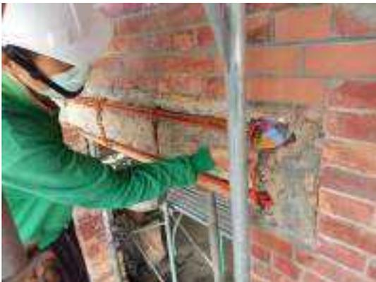
照片 5-167 門楣鋼筋植筋完成後新舊鋼筋均刷塗防鏽漆
