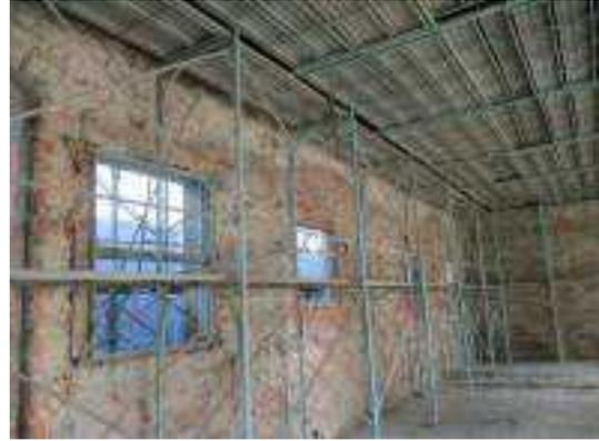
照片 4-26 內部施工架搭設完成
