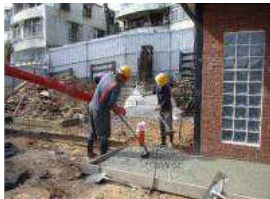
照片 6-72 混凝土步道210kg/cm<sup>2</sup>混凝土打築
