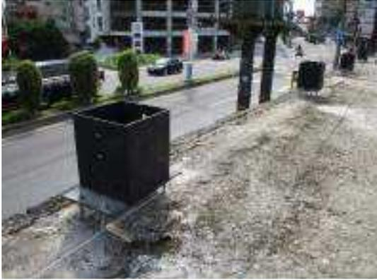
照片 6-75 木製欄杆鋼製基座安裝固定
