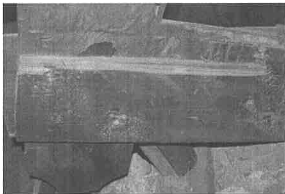
【附圖 6-3-42】第一檢查場屋架 F3-2-2 構件表面破損
