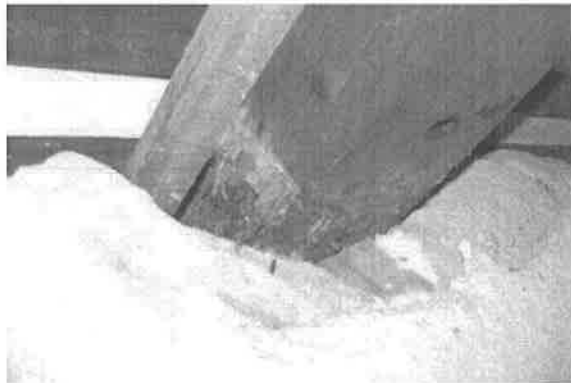
【附圖 6-3-24】第一檢查場 F3~W3 區間屋桁 9 端部腐朽
