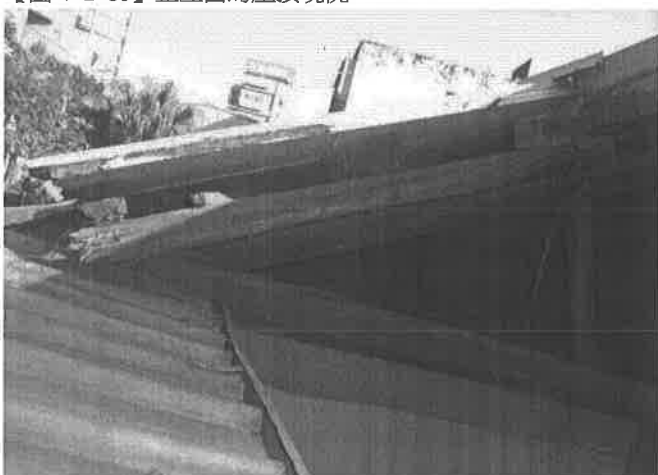
【圖 4-2-82】鐵皮浪板與隔熱層直接落在屋桁上
