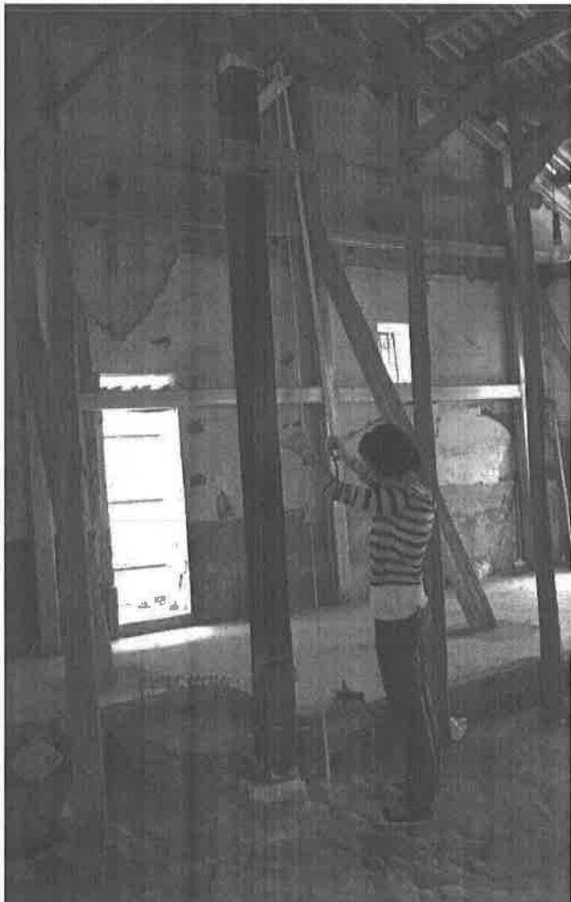
【圖 4-2-12】G9 屋架正下方有磚柱基礎的痕跡
