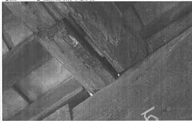
【圖 5-2-5】桁木搭接觸鬆脫
