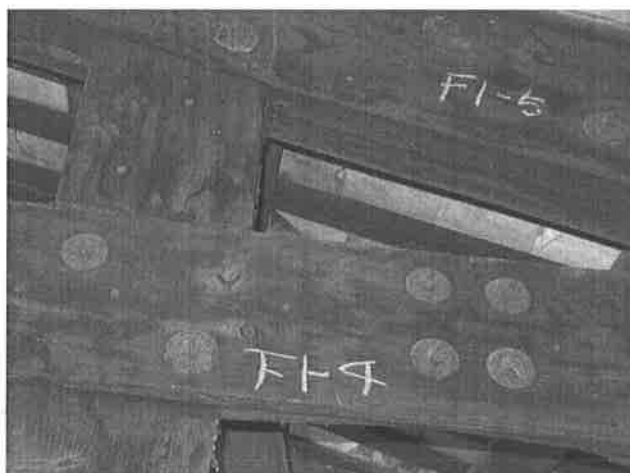
【圖 4-1-83】拼接板材、連繫材襯板上皆留下鐵釘痕
