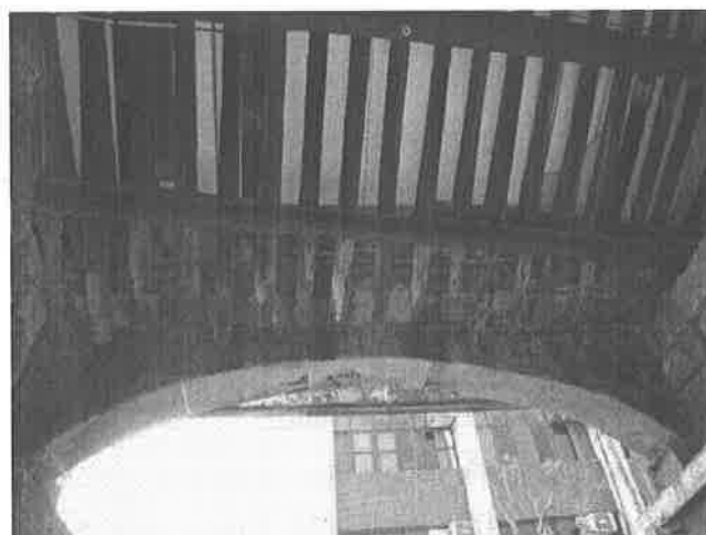
【圖 5-1-29】磚砌牆體拱型開口
