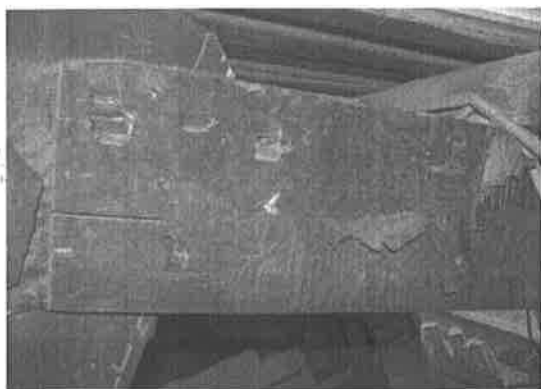
【附圖 6-3-41】第一檢查場屋架 F3-1-2 構件開裂現況
