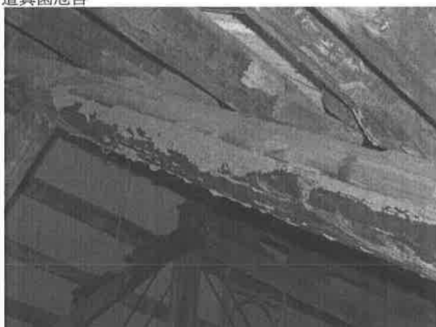
【圖 6-3-5】輸入品倉庫建築遭生物性因子危害現況：屋架構件佈滿白蟻分飛孔
