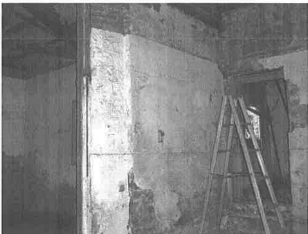
【圖 4-2-44】屋架 G4 水平樑下磚石牆，下部為石，上部為尺磚
