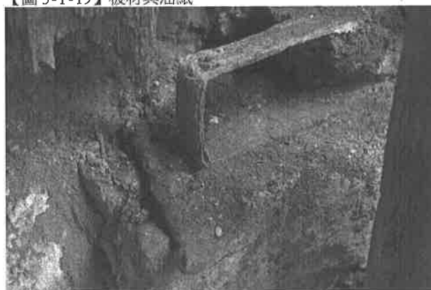
【圖 5-1-21】木構架 F3 南側端部之鐵件
