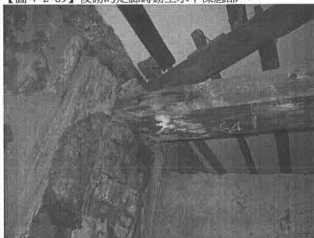
【圖 4-2-71】屋架南側搭在石柱上
