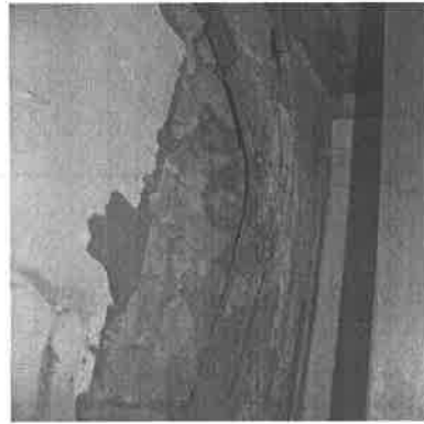
【附圖 6-3-32】第一檢查場屋架 F1-5-12 構件開裂與變形現況
