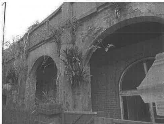
【圖 3-2-6】後棟的拱廊及女牆立面出現時間較早，推測是大正年間轉作宿舍時增設
