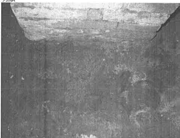
【圖 4-2-59】屋架 G8 下磚柱底部為夯土、卵石
