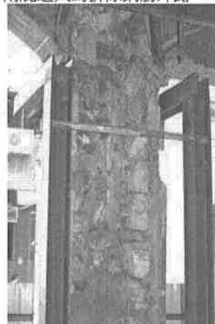
【圖 5-2-29】柱 C4 柱身由磚石混砌
