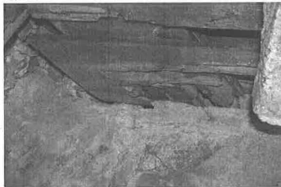
【附圖 6-3-29】第一檢查場屋架 F1-5-1 構件蛀蝕嚴重
