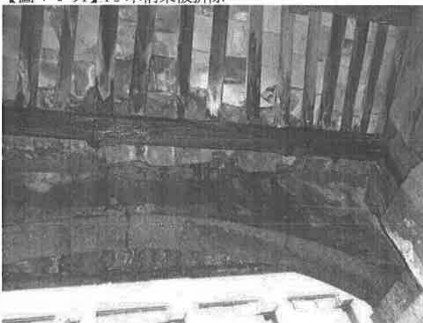
【圖 4-1-93】B 空間第一支桁木，潮濕、腐朽
