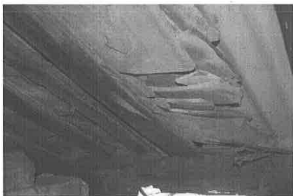
【附圖 6-3-21】第一檢查場 F2~W2 區間屋桁 16 腐蝕嚴重
