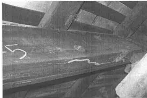
【附圖 6-3-31】第一檢查場屋架 F1-5-10 構件白蟻表面蛀蝕
