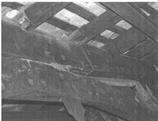
【圖 6-3-2】第一檢查場建築遭生物性因子危害現況：屋架構件遭受白蟻表面蛀蝕及發現一處蟻道
