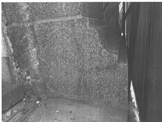
【圖 3-3-5】立面磚柱基座線腳
