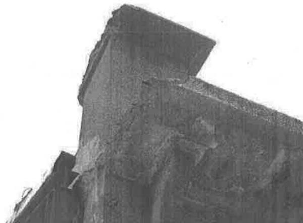
【圖 5-2-27】雨庇遭人為拆除鋼筋外露
