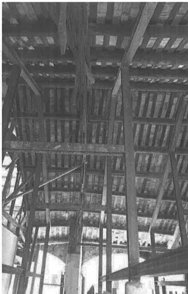
【圖 4-1-87】F2 木構架整組向西傾斜
