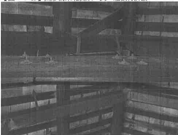
【圖 4-1-71】木拱 F1-2 與 F1-4 板材拼接接縫錯開，左側四顆螺栓主要為固定他側拼接板材
