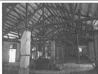
屋架與磚柱為同一結構系統
