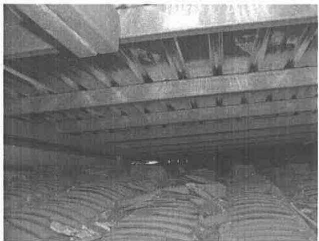
【圖 4-1-98】A 組屋頂利用鋼架鐵皮包覆傳統屋頂
