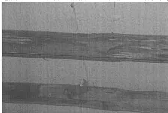
【附圖 6-3-56】輸入品倉庫 G4~G5 屋桁右 9 蛀空
