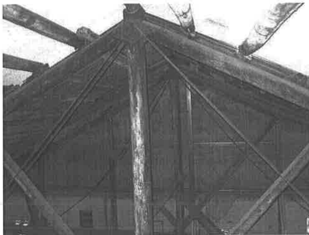
【圖 4-2-78】可見後一屋架拉力桿鬆弛彎曲
