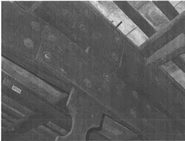
【圖 4-1-69】山形構架北側以二長一短板材拼接
