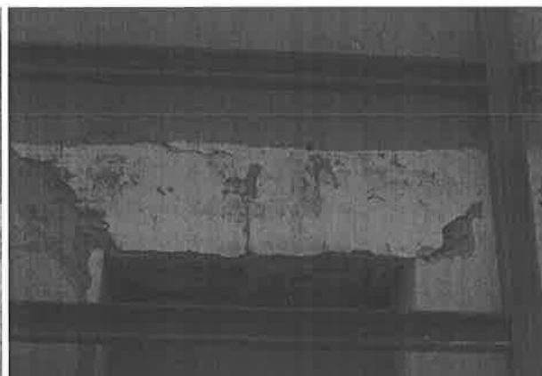
【圖 5-2-22】開口部剪力裂縫
