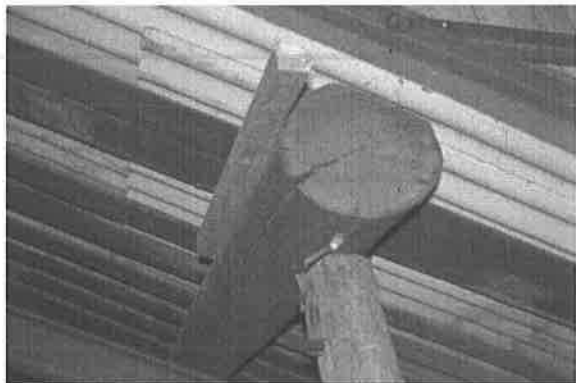
【附圖 6-3-19】第一檢查場 F2~W2 區間屋桁 10 遭白蟻蛀蝕
