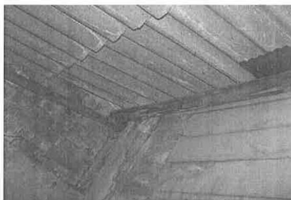
【附圖 6-3-66】輸入品倉庫 G5~G6 屋桁右 20 蛀蝕
