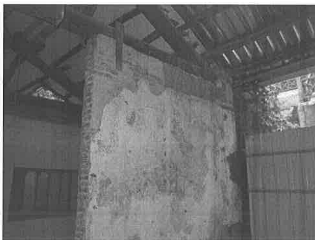
【圖 4-2-53】屋架 G8 下以尺磚與石材混合砌成的牆體
