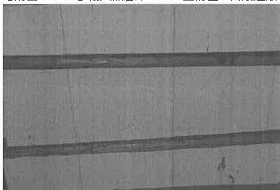
【附圖 6-3-54】輸入品倉庫 G4~G5 屋桁左 3 蛀蝕與乾裂
