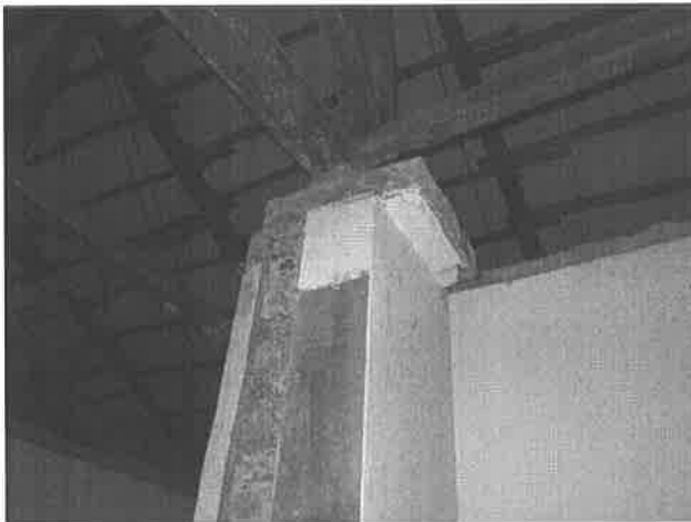
【圖 4-2-64】屋架 G2 下磚柱部份被拆除
