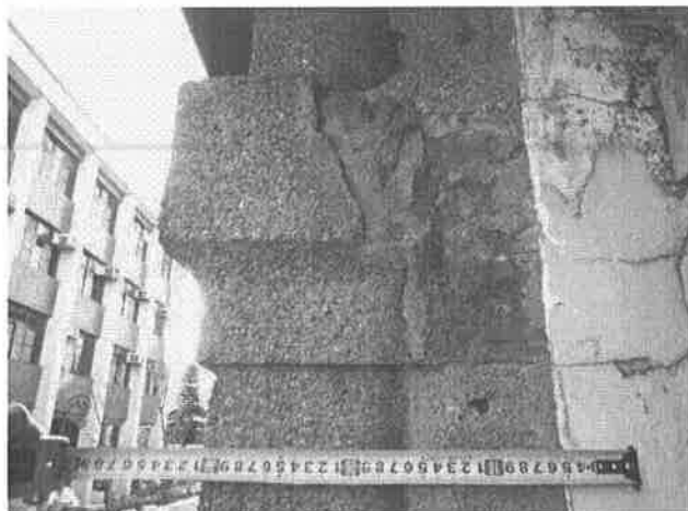
【圖 4-1-50】洗石子線腳遭拆除
