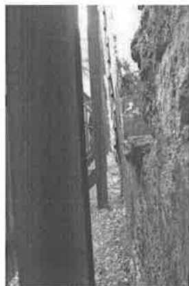
【圖 5-1-43】西側山牆往西側傾斜
