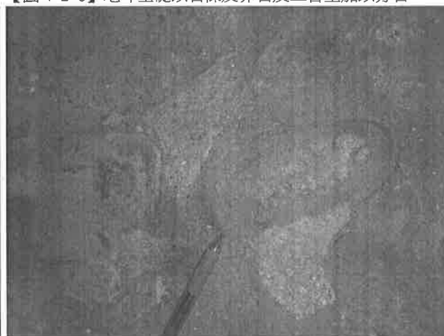
【圖 4-2-8】裸露處可看出基礎施作材料有卵石及三合土
