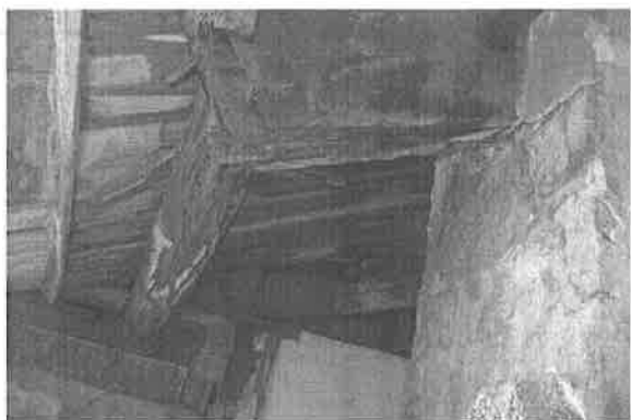
【附圖 6-3-35】第一檢查場屋架 F2-1-9 構件白蟻蛀蝕嚴重
