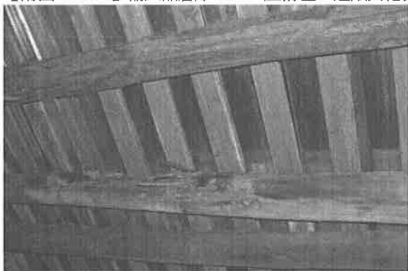
【附圖 6-3-85】輸入品倉庫 G9~W2 屋桁右 9 蛀空與乾裂
