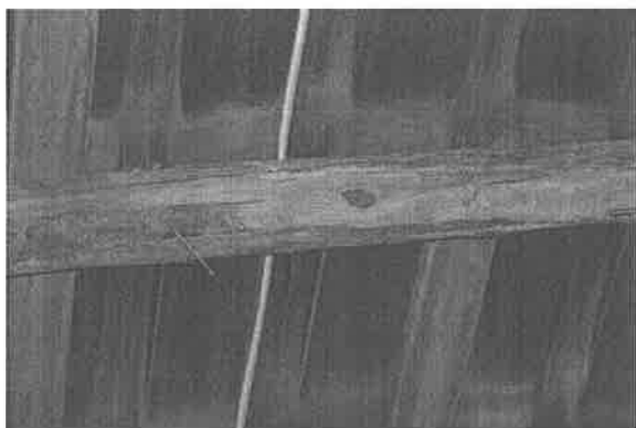
【附圖 6-3-81】輸入品倉庫 G8~G9 屋桁右 13 蛀空
