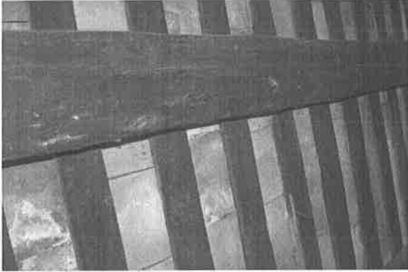
【附圖 6-3-11】第一檢查場 F1~F2 區間屋桁 13 白蟻蛀蝕
