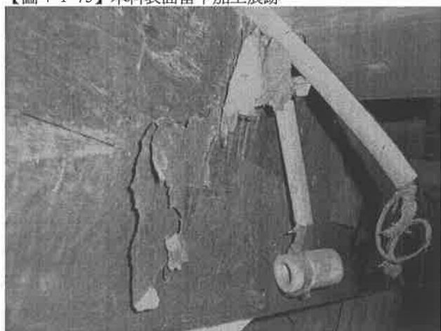
【圖 4-1-77】F3 木構架，板材間夾油紙的狀況(
