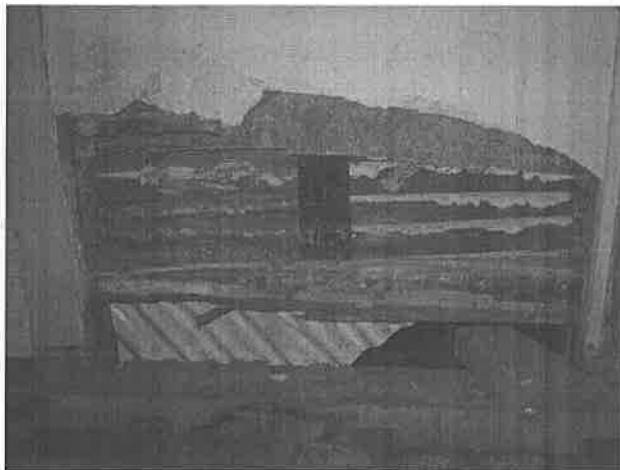
【圖 4-1-57】粉刷層剝落、木榴腐朽
