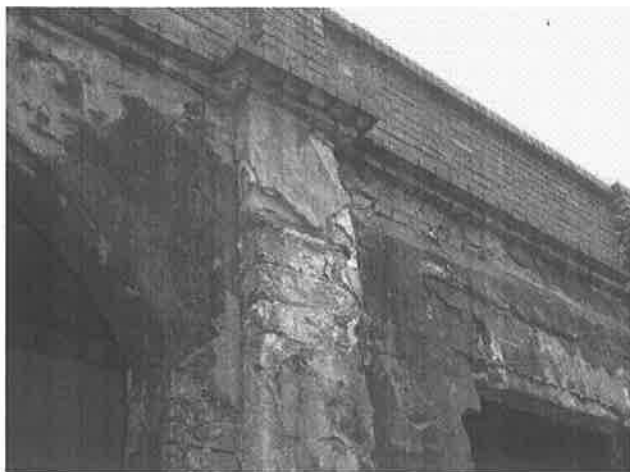
【圖 4-2-34】南側立面原有石柱與後砌磚拱
