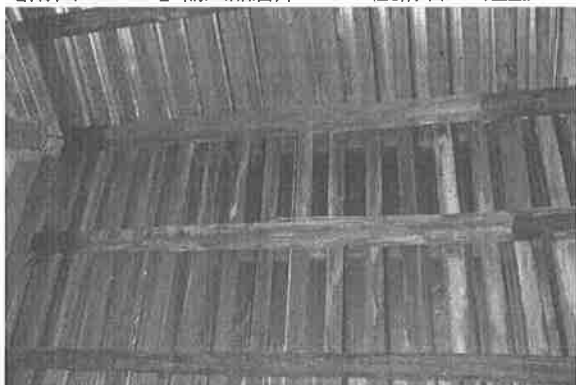
【附圖 6-3-83】輸入品倉庫 G9~W2 屋桁左 1 蛀蝕與乾裂
