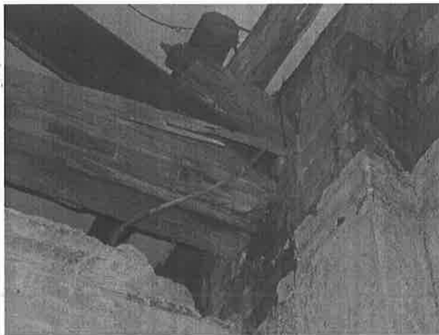
【圖 5-4-12】南面受潮端點腐朽
