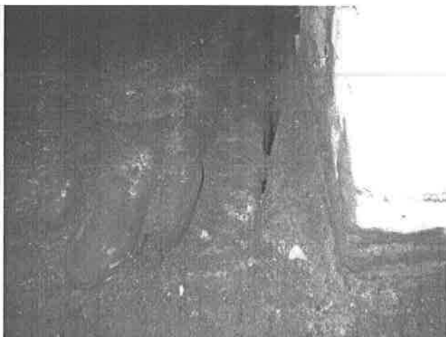
【圖 4-2-10】此照可看出石條位於磚柱及卵石的下方
