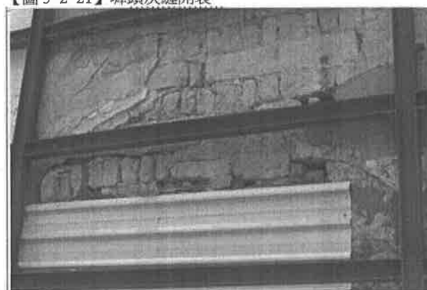
【圖 5-2-23】中央開口部開裂及磚拱
