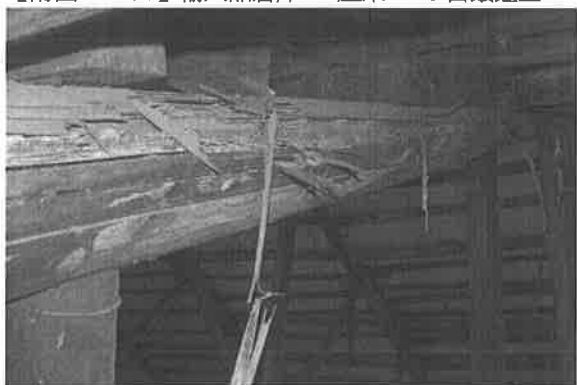
【附圖 6-3-99】輸入品倉庫 G6 屋架 V1-1 蛀蝕與乾裂
