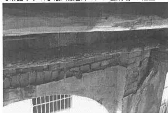
【附圖 6-3-79】輸入品倉庫 G8~G9 屋桁左 15 蛀空與乾裂
