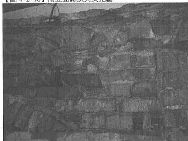
【圖 4-2-48】南立面磚拱室內側，砌工不規則
