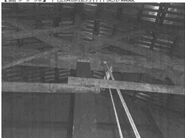
【圖 3-3-32】缺乏磚柱的屋架，水平樑中央以木柱支撐
