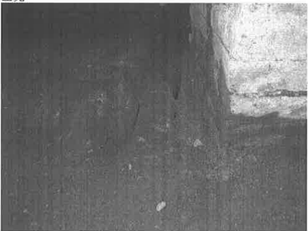
【圖 4-2-60】屋架 G6 下磚柱直接壓在石板路上，三者上下關係為石板路最底、再來為磚柱與卵石
