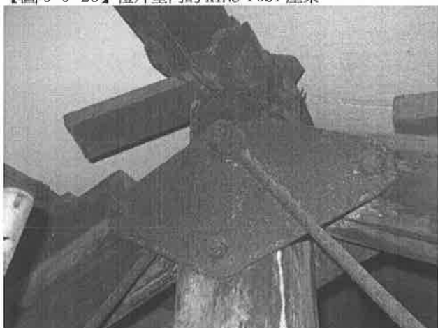
【圖 3-3-30】中柱頂部拉力桿件菱形鐵板
