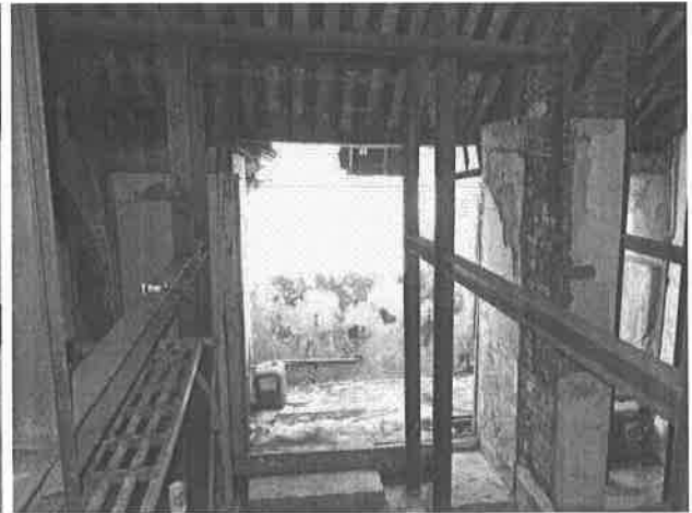
【圖 4-1-45】F2 立柱被磚牆包覆
