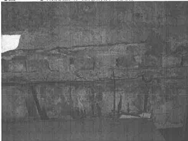
【圖 4-1-42】磚拱、RC 雨庇以及上部女兒牆，部份屋瓦仍殘留在女兒牆內
