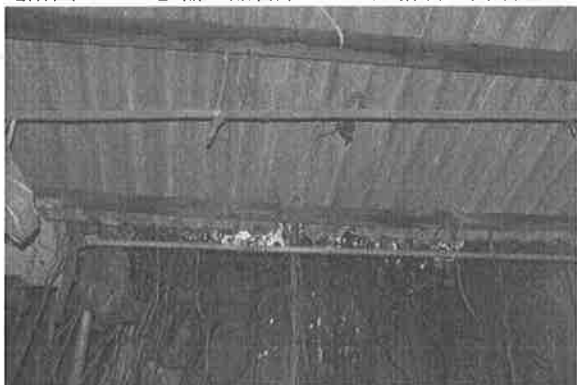
【附圖 6-3-67】輸入品倉庫 G5~G6 屋桁右 21~右 22 佚失
