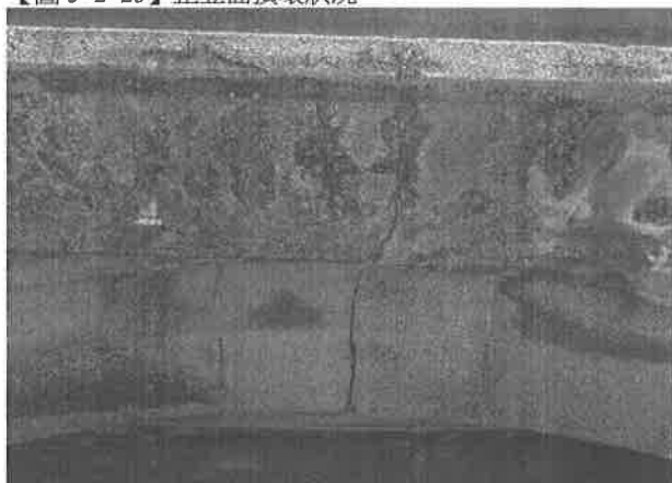
【圖 5-2-26】拱心處開裂至雨庇
