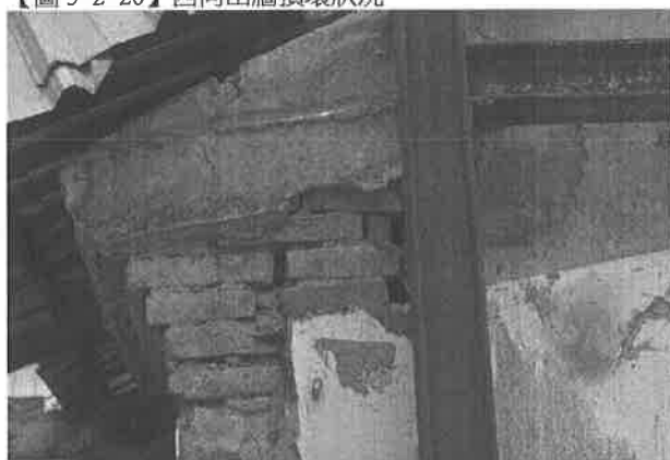
【圖 5-2-21】樑頭灰縫開裂
