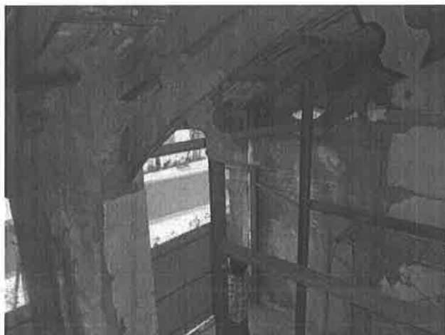
【圖 4-1-85】F1 與 F2 木構架被石牆與磚牆包覆
