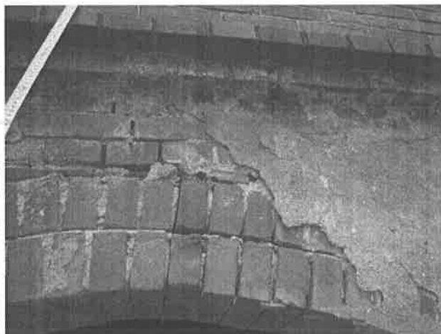
【圖 4-2-47】立面磚拱，可見磚材品質差，砌工也不佳
