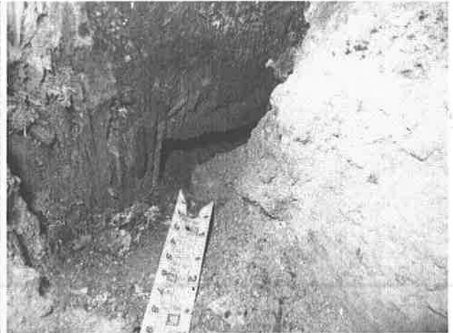
【圖 4-1-66】木構架 F1-5 北側立柱底端可見一清楚槽孔，直尺抵住者為 C 形鐵件
