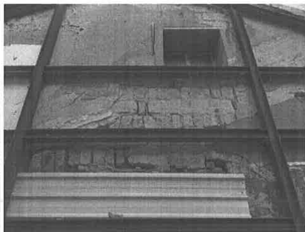
【圖 4-1-30】西山牆開口部石材多有擾動痕跡
