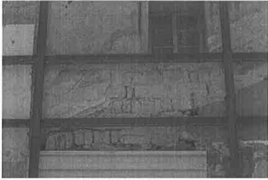
【圖 5-1-38】西側山牆整層方石砌
