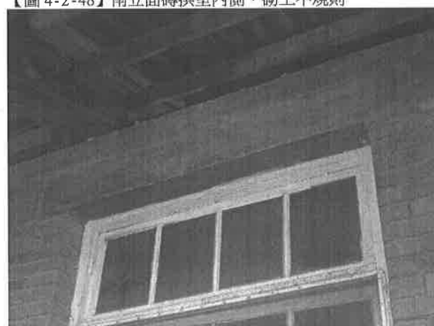
【圖 4-2-50】走廊磚牆開窗上部施作仿石灰泥
