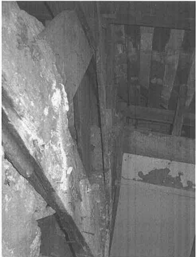
【圖 4-1-64】左圖方框區近照，二片立柱內沒有木構件
