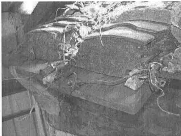
【圖 4-1-104】瓦片尾端以座灰與尺磚收頭
