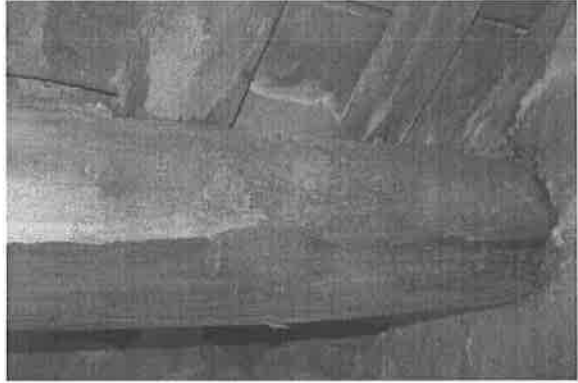
【附圖 6-3-14】第一檢查場 F2~W2 區間屋桁 1 腐朽嚴重
