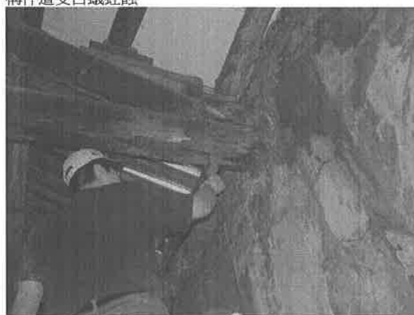
【圖 6-3-8】輸入品倉庫建築遭生物性因子危害現況：屋架構件遭受真菌危害
