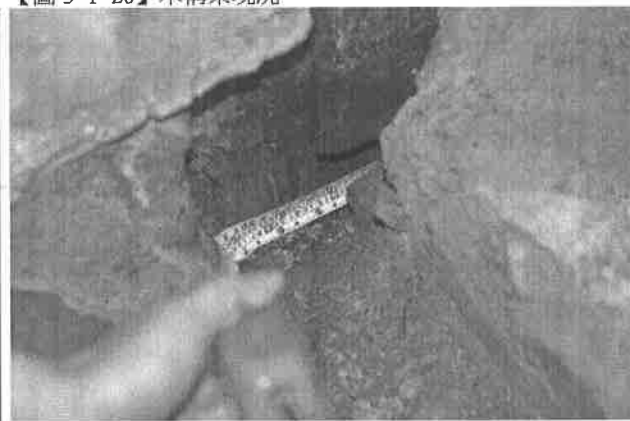
【圖 5-1-22】木構架 F1 北側端部之鐵件
