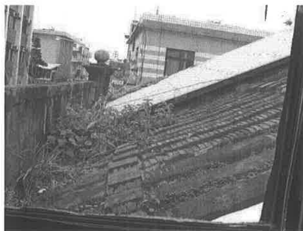
【圖 6-3-4】第一檢查場建築遭生物性因子危害現況：屋瓦發現植物生長
