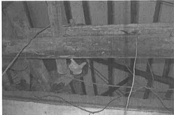
【附圖 6-3-93】輸入品倉庫 G3 屋架 H2-1 蛀蝕與乾裂
