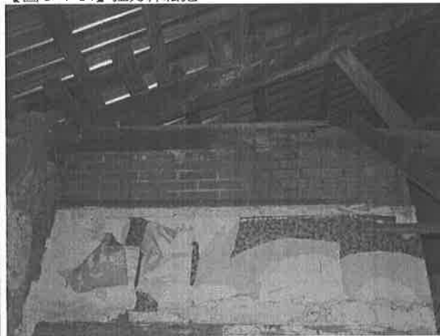
【圖 5-4-16】屋架下陷導致水平樑破壞
