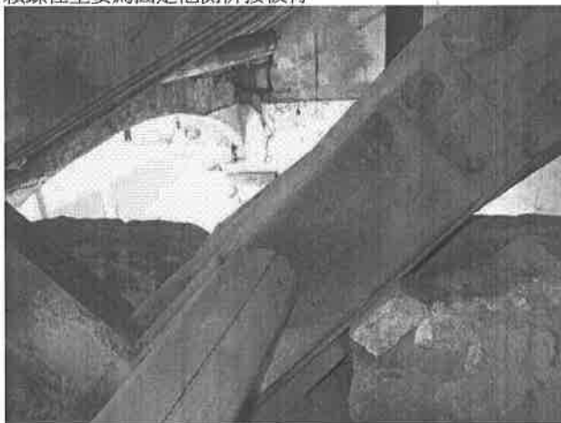
【圖 4-1-73】木拱 F1-4 第 3 段，其外側加設一襯板
