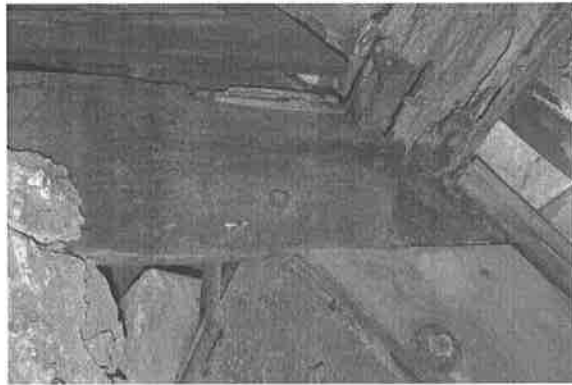
【附圖 6-3-30】第一檢查場屋架 F1-5-2 構件蛀蝕嚴重
