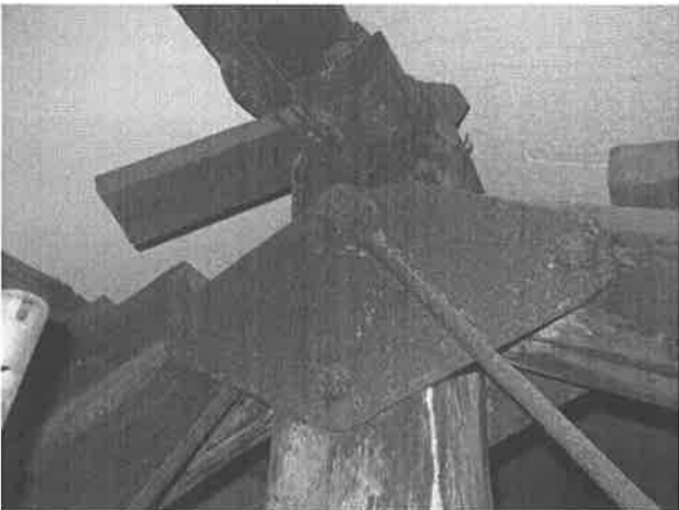
【圖 4-2-76】拉力桿頂部接合方式，一支拉力桿在內側，另一則在外
