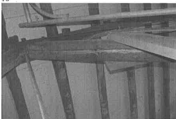
【附圖 6-3-102】輸入品倉庫 G7 屋架 V0 蛀蝕與乾裂
