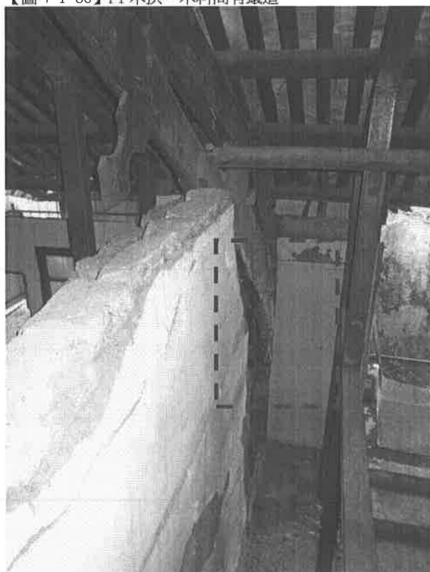
【圖 4-1-88】F1 木構架，北側立柱向東則變形
