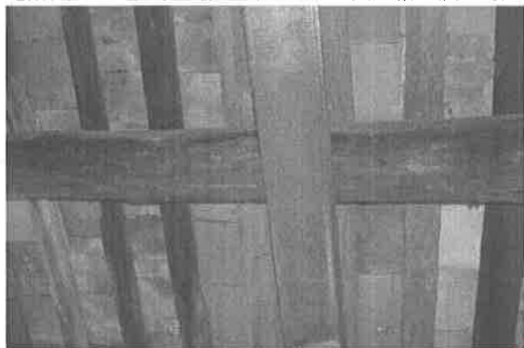
【附圖 6-3-7】第一檢查場 F1~F2 區間屋桁 3 遭白蟻蛀蝕
