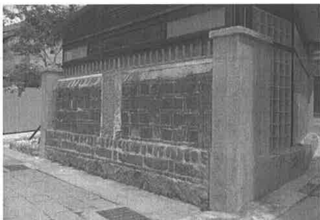
【圖 3-1-9】原石炭棧區外牆採閩南傳統的斗砌磚牆造
