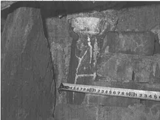
【圖 4-1-38】第二磚柱內埋設陶管
