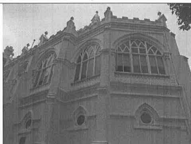
多角形立面外側加設扶壁柱
