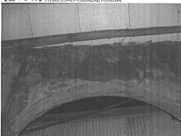
【圖 4-2-83】拱圈頂端還留有閩南瓦的殘跡
