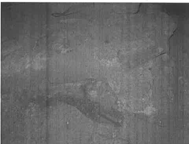
【圖 4-2-61】屋架 G9 下原磚柱基礎上留有黑色薄瓦片，應為防水用
