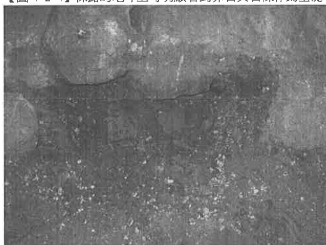
【圖 4-2-5】地坪基礎以石條為底材，中間回填碎料
