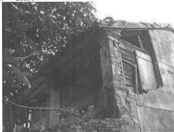
【圖 3-1-22】淡水少數留存的柱樑式外廊的二層洋樓，柱身為磚造，以構造來看年代亦相當早
