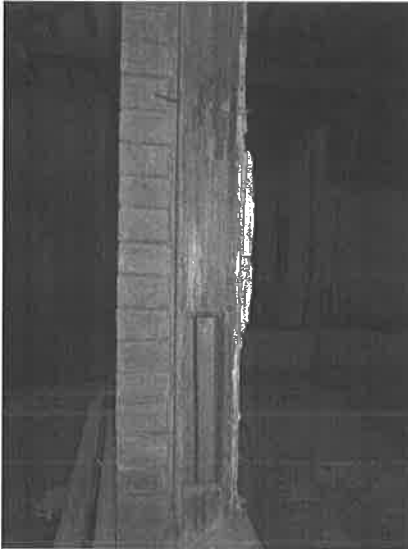
【圖 4-2-101】W4 窗，窗框旁可見重錘放置口
