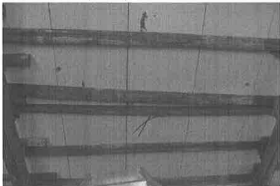
【附圖 6-3-87】輸入品倉庫 G2 屋架 V1-1 蛀蝕與乾裂
