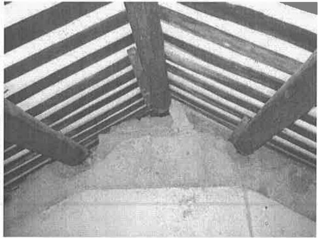
【圖 3-3-8】木桁搭在石砌山牆頂部
