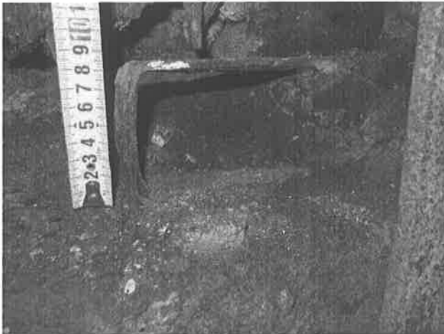
【圖 4-1-65】木構架 F3-1 保留立柱 C 形鐵件
