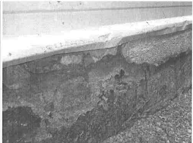
【圖 4-1-3】石砌牆底部仍為石條砌
