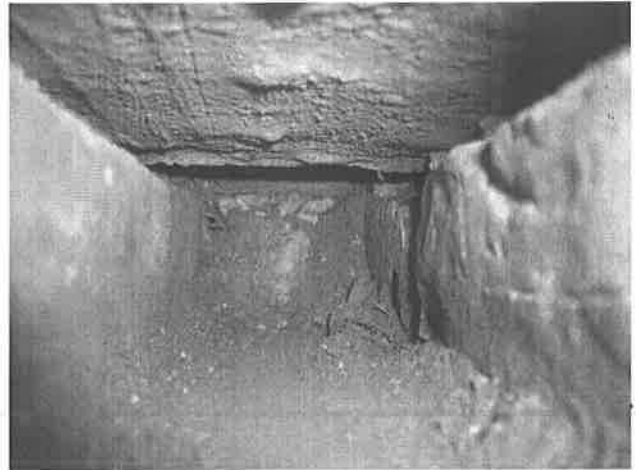
【圖 4-2-63】填縫用的小磚被挖除後，可見內部填土料等材料
