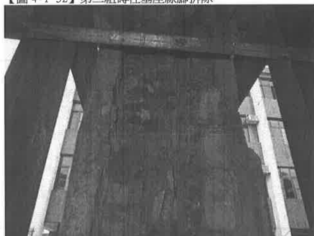
【圖 4-1-54】第四組磚柱內部被拆除
