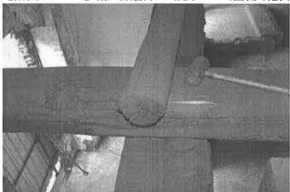
【附圖 6-3-103】輸入品倉庫 G7 屋架 H1-1 蛀空乾裂
