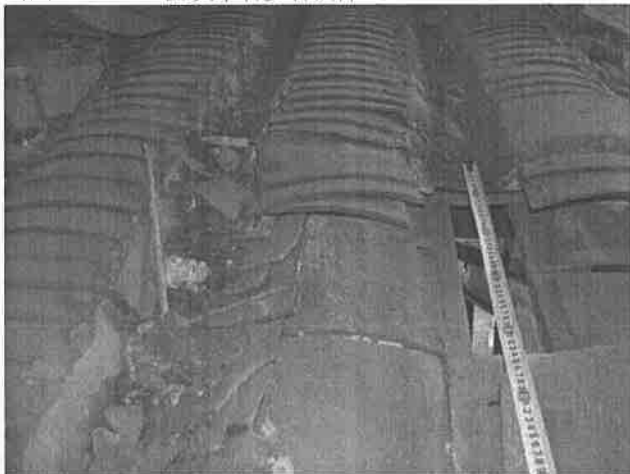
【圖 4-1-102】第一層俯瓦的鋪設
