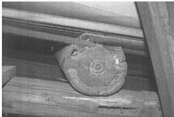
【附圖 6-3-20】第一檢查場 F2~W2 區間屋桁 12 白蟻蛀蝕嚴重
