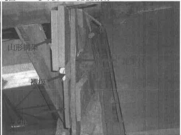
【圖 4-1-72】F3 木構架，可見連繫材以及其襯板
