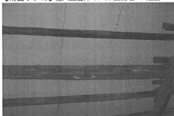
【附圖 6-3-77】輸入品倉庫 G7~G8 屋桁右 15 蛀空
