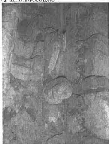
【圖 5-1-28】柱 C4 柱身為磚石混砌
