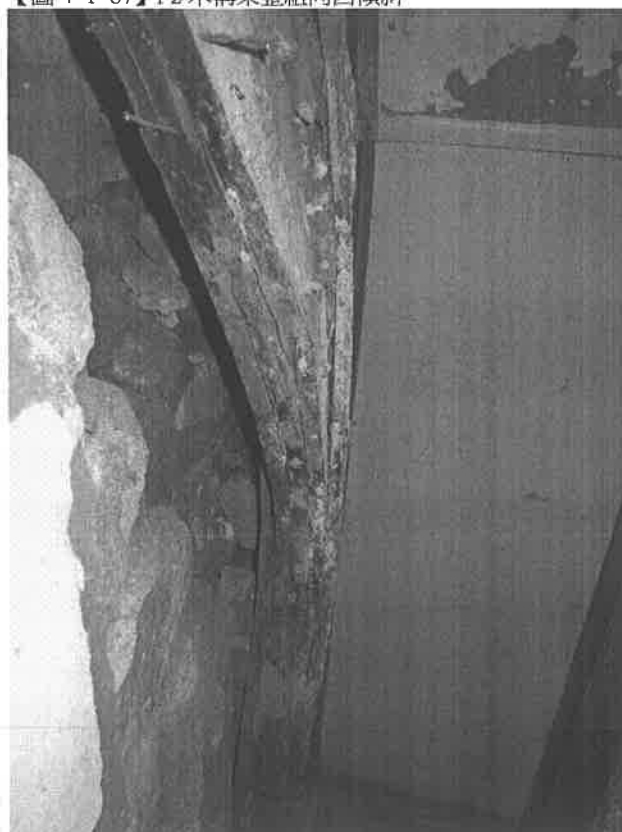
【圖 4-1-89】左圖方框區近照，其構造脫出牆面
