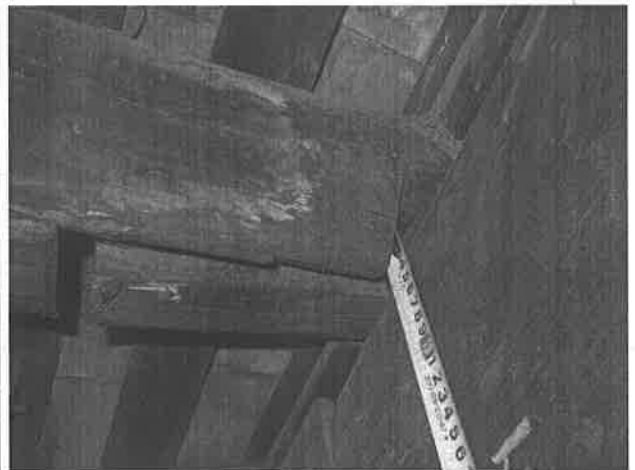
【圖 4-1-74】桁木本身以及與山形構架搭接
