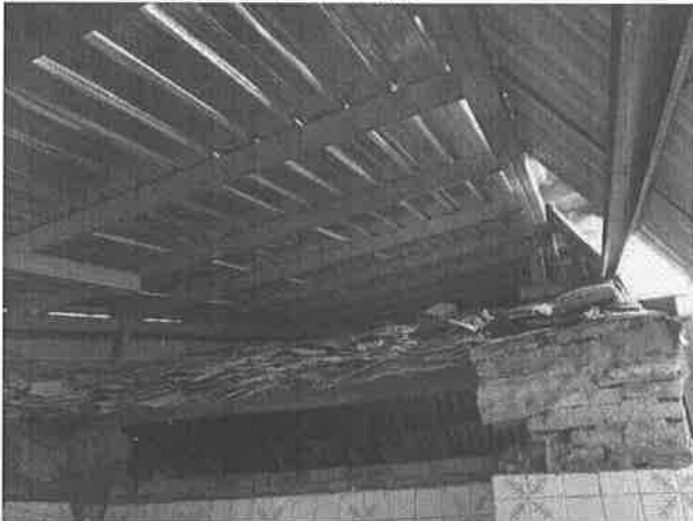
【圖 4-1-107】A 屋頂的鐵皮直接鎖在鋼架上
