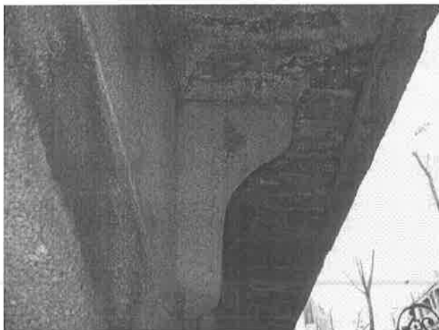
【圖 3-3-3】鋼筋混凝土兩庇與洗石子牆面
