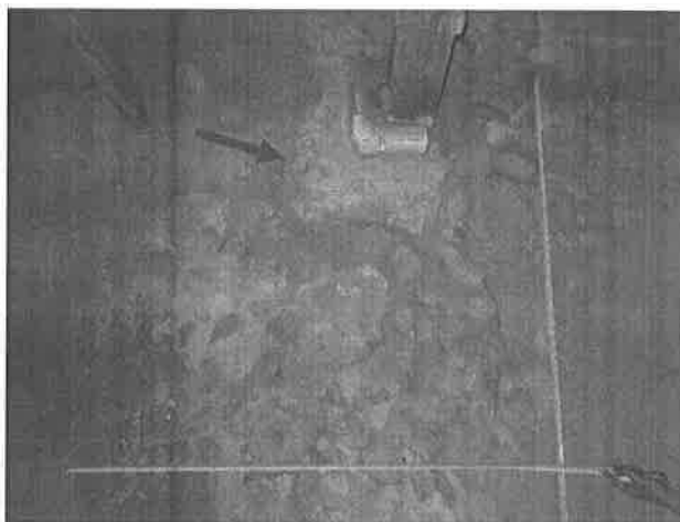
【圖 4-2-57】屋架 G9 下原有磚柱基礎，在周圍卵石間更為明顯
