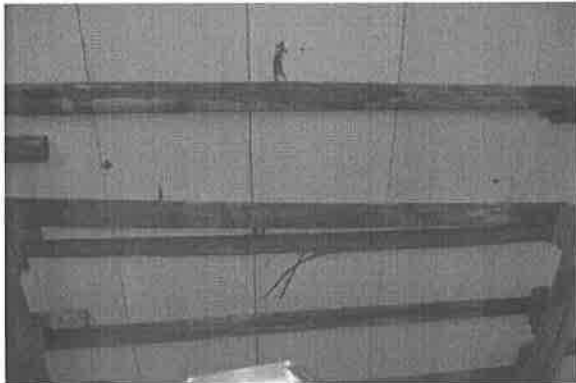
【附圖 6-3-63】輸入品倉庫 G5~G6 屋桁左 6 蛀蝕與乾裂
