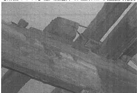
【附圖 6-3-100】輸入品倉庫 G6 屋架 V2-1 蛀空與發現分飛孔
