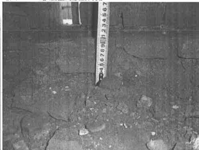
【圖 4-2-17】牆基以不完整的尺磚、石塊疊砌
