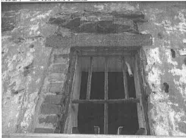
【圖 4-2-98】東山牆原有開窗，石條上方留有雨底痕跡
