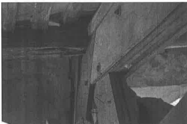
【圖 5-2-6】桁木與桷木腐朽
