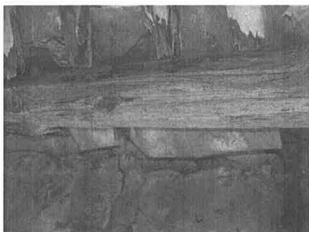
【圖 6-3-3】第一檢查場建築遭生物性因子危害現況：屋桁遭真菌危害
