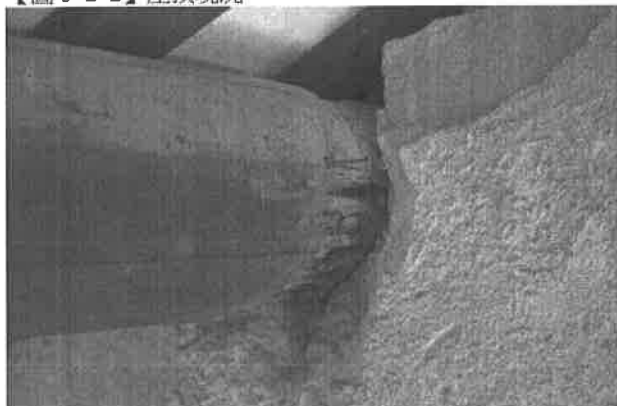
【圖 5-2-4】條端部腐朽
