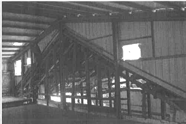
【圖 5-2-3】屋面及桁木損壞
