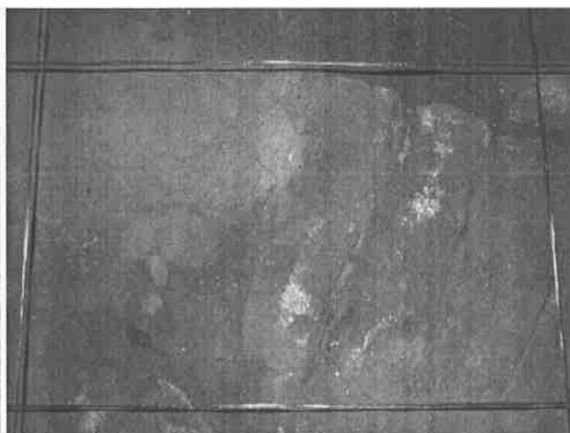
【圖 4-2-6】地坪基礎以石條及卵石及三合土加以夯石
