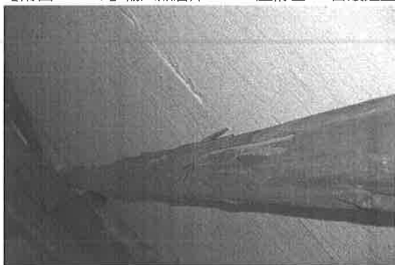
【附圖 6-3-51】輸入品倉庫 G3~G4 屋桁左 7 白蟻蛀蝕
