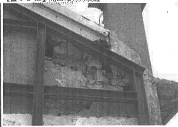
【圖 5-2-24】角隅石塊部分脫落
