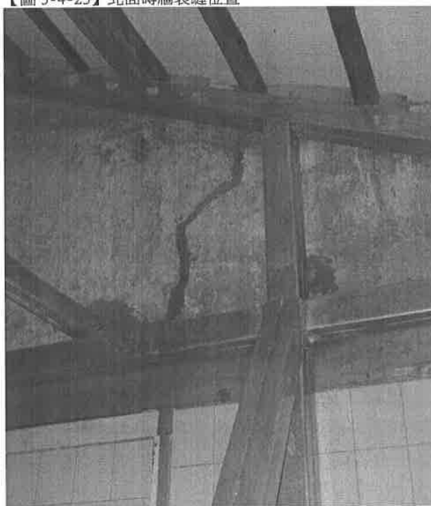
【圖 5-4-23】北面磚牆裂縫位置
