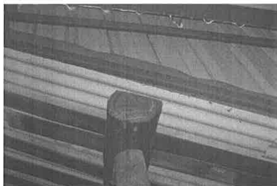
【附圖 6-3-18】第一檢查場 F2~W2 區間屋桁 9 遭白蟻蛀蝕
