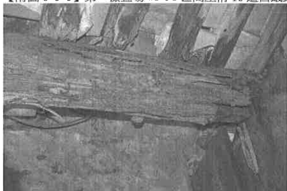
【附圖 6-3-5】第一檢查場 F1~F2 區間屋桁 1 腐蛀嚴重
