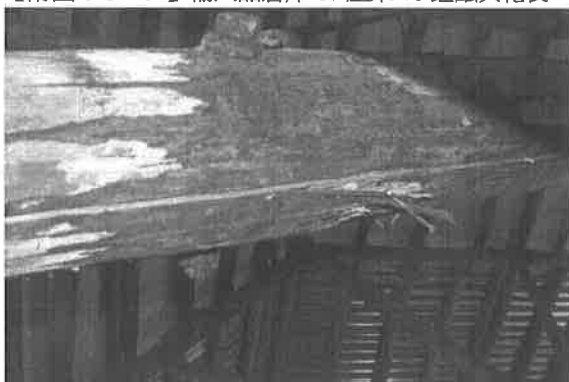
【附圖 6-3-104】輸入品倉庫 G7 屋架 H2-1 蛀空乾裂
