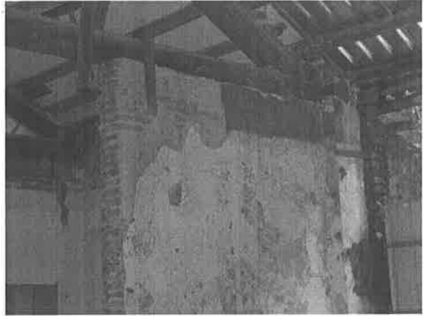
【圖 6-3-10】輸入品倉庫建築遭非生物性因子危害：壁體破損及粉刷層剝落
