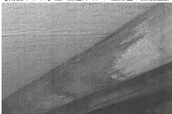
【附圖 6-3-53】輸入品倉庫 G4~G5 屋桁左 10 腐朽與乾裂
