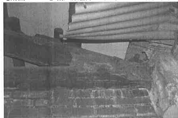
【附圖 6-3-96】輸入品倉庫 G5 屋架 V2-1 蛀空與乾裂
