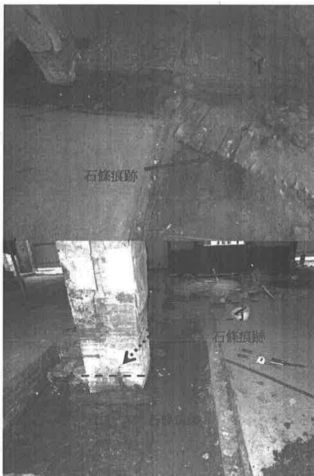
【圖 4-2-3】石條呈現規律的排列，直到磚柱下方還有其痕跡
