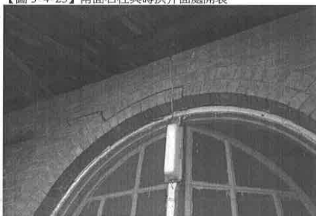
【圖 5-4-27】內層磚牆開裂
