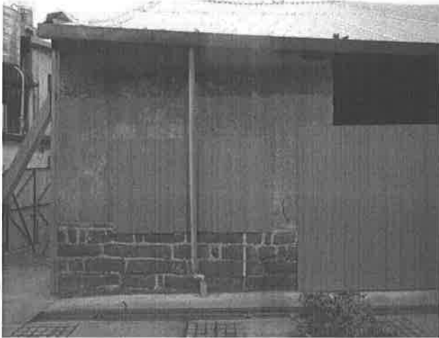
【圖 5-3-23】牆體底層石條基牆
