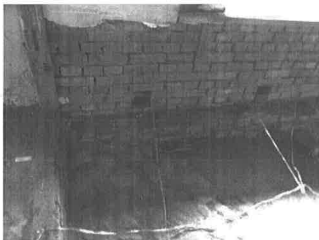
【圖 4-2-14】F 空間南側磚牆的牆基
