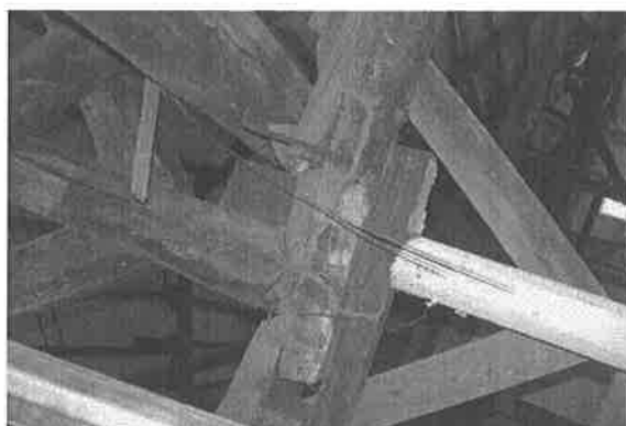
【附圖 6-3-98】輸入品倉庫 G5 屋架 H2-1 蛀蝕與乾裂
