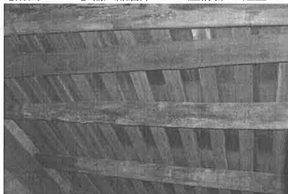
【附圖 6-3-84】輸入品倉庫 G9~W2 屋桁右 7 中間段腐朽
