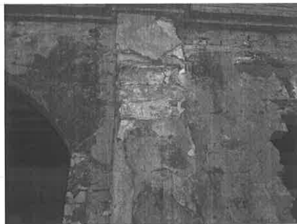
【圖 3-1-23】後棟外突的石砌柱，即是原有柱子
