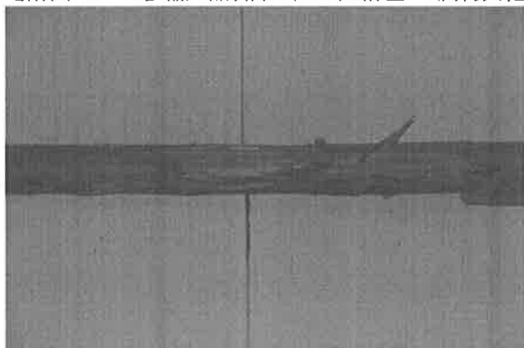
【附圖 6-3-55】輸入品倉庫 G4~G5 屋桁中脊蛀蝕
