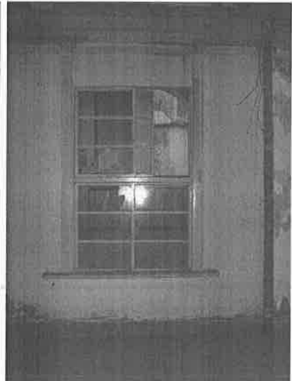
【圖 4-2-102】W7 窗，上部氣窗封起，下部改為左右推拉窗
