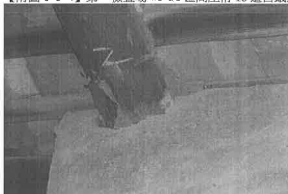
【附圖 6-3-6】第一檢查場 F1~F2 區間屋桁 2 發現分飛孔
