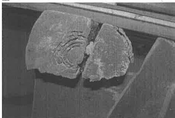
【附圖 6-3-22】第一檢查場 F3~W3 屋桁 3 白蟻蛀蝕嚴重
