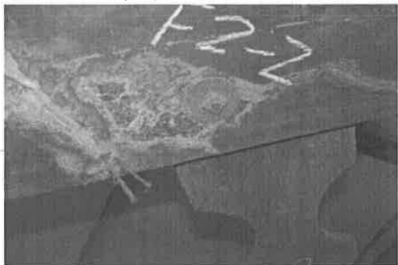
【附圖 6-3-37】第一檢查場屋架 F2-2-8 白蟻表面蛀蝕
