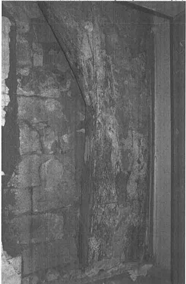
【圖 3-3-19】木拱最後與立柱相接合，變成立柱的一部份
