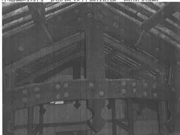
【圖 4-1-59】F2 木構架。以 U 型鐵件加強山形構架與桁木搭接
