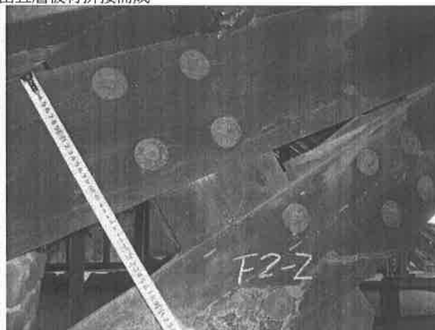
【圖 3-3-14】山形構架與木拱之連繫材，連繫材突出山形構架與木拱
