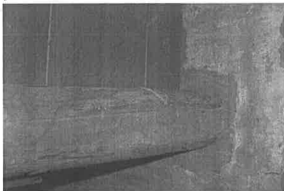
【附圖 6-3-28】第一檢查場 F3~W3 閣樓屋桁 8 蛀蝕嚴重
