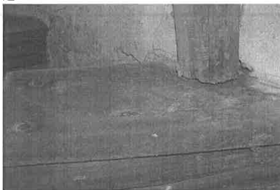
【附圖 6-3-36】第一檢查場屋架 F2-2-1 構件白蟻蛀蝕嚴重
