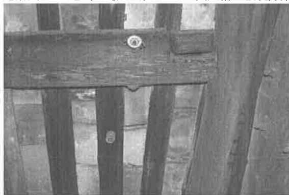
【附圖 6-3-8】第一檢查場 F1~F2 區間屋桁 4 遭白蟻蛀蝕
