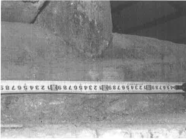
【圖 4-2-74】中柱與水平樑搭接採單直桿
