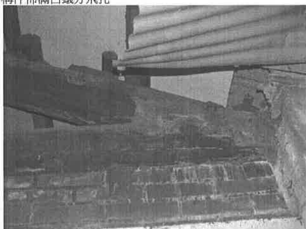
【圖 6-3-7】輸入品倉庫建築遭生物性因子危害現況：屋架構件交接處發現白蟻副蟻巢
