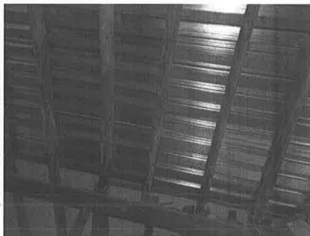
【圖 4-2-87】桁材上方覆蓋鋁質隔熱板
