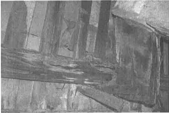
【附圖 6-3-13】第一檢查場 F1~F2 區間屋桁 16 發現分飛孔，
