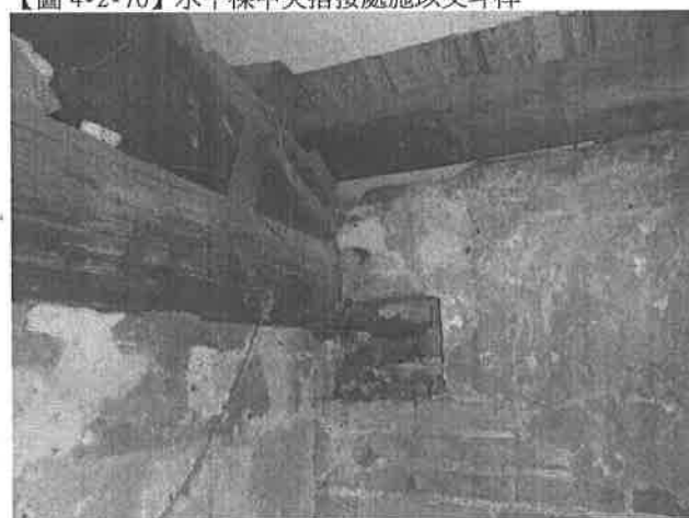
【圖 4-2-72】屋架北側跨座在斗砌牆上
