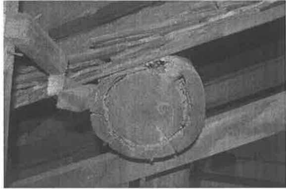
【附圖 6-3-16】第一檢查場 F2~W2 區間屋桁 3 白蟻蛀蝕嚴重
