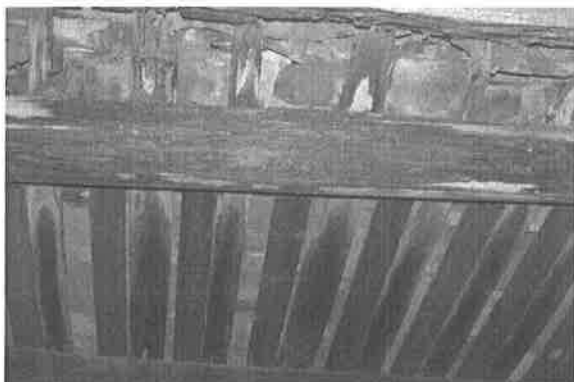
【附圖 6-3-1】第一檢查場 W1~F1 區間屋桁 1 遭白蟻蛀蝕
