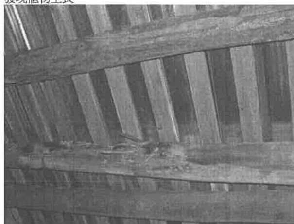
【圖 6-3-6】輸入品倉庫建築遭生物性因子危害現況：屋桁構件遭受白蟻蛀蝕
