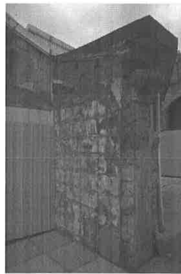
【圖 5-2-19】石條土塊及磚混砌之矮牆
