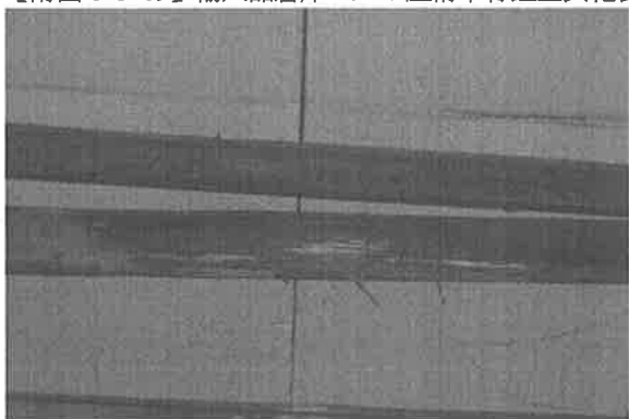
【附圖 6-3-71】輸入品倉庫 G6~G7 屋桁右 11 蛀空
