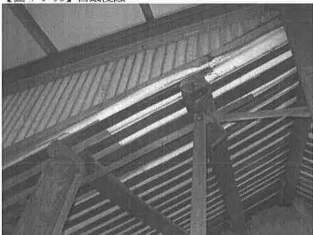
【圖 4-1-92】D 空間桁木被鋸除，U 型鐵件亦被破壞
