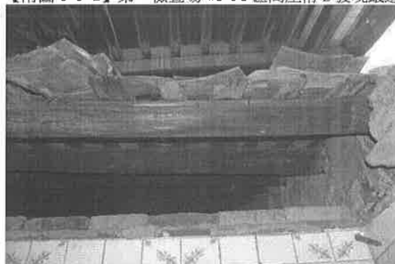
【附圖 6-3-4】第一檢查場 W1~F1 區間屋桁 16 遭白蟻蛀蝕
