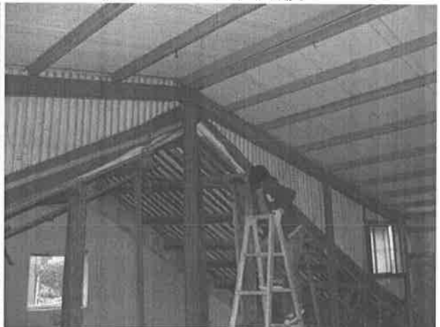
【圖 4-1-108】C 空間以鋼架架高屋頂，鋼架上鋪 PU 泡棉隔熱板
