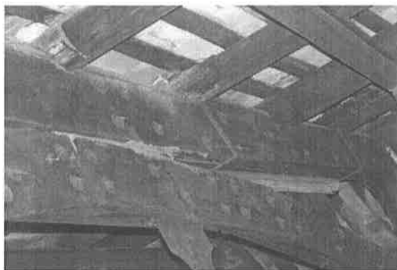
【附圖 6-3-34】第一檢查場屋架 F2-1-6 構件開裂與發現蟻道
