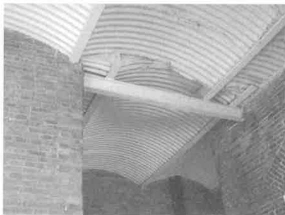
照片8 左右迴廊之波形鐵板拱
