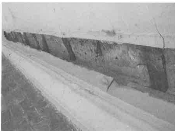
照片7 前廊二樓樓板型鋼樑及混凝土構造
