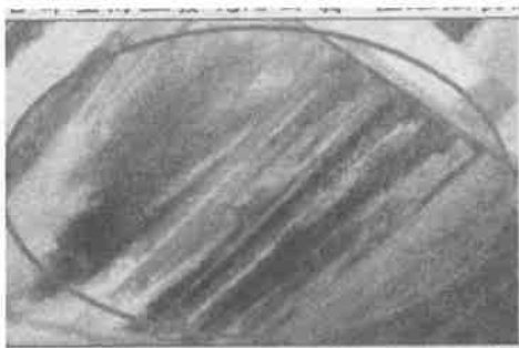
圖3 領事官邸屋面板因漏水而有腐朽劣化之情形
