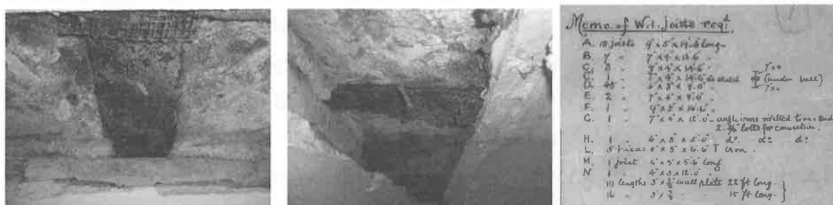
圖14 前清淡水英國領事官邸熟鐵小梁格欄柵樓板(左一、二)及熟鐵小梁尺寸表(右)
