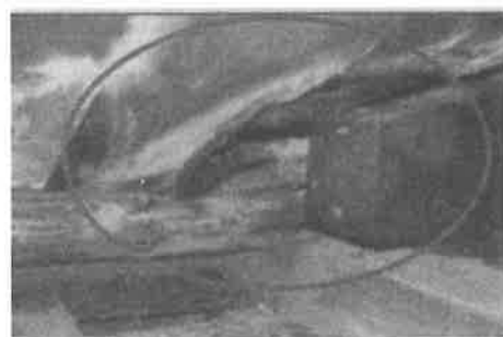
圖8 辦公室屋桁因漏水而造成軟腐菌侵蝕嚴重
