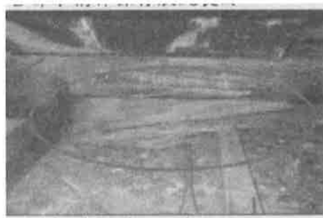
圖4 會議室屋桁遭白蟻蛀空腐朽劣化之情形
