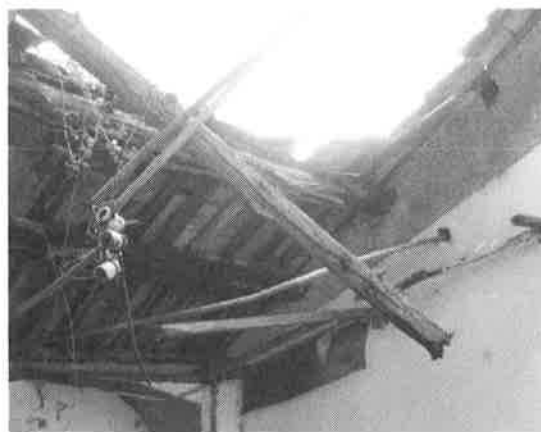
照片【3-3-15】 屋頂的破損狀況。
