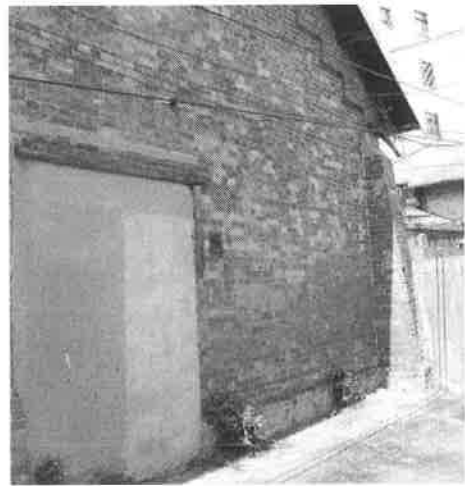
照片【3-3-11】 南向山牆面出入口被混凝土封住之痕跡。
