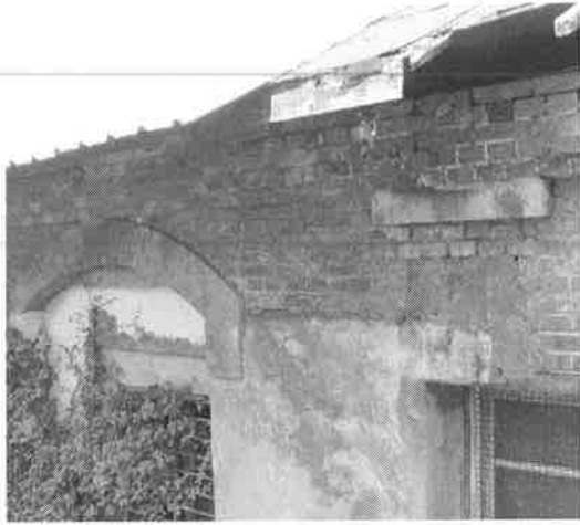
照片【3-3-8】 東向立面上一根扶壁柱被拆除，下方加設開窗。
