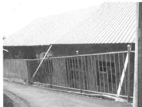
照片【3-4-108】北側屋頂加設臨時保護棚架
