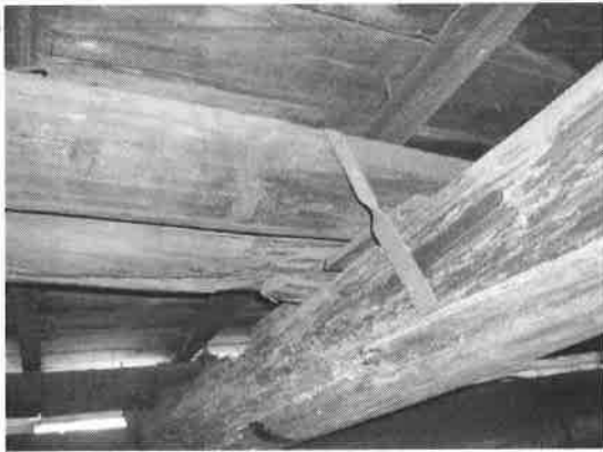
照片【3-4-105】木構件蛀蝕及鐵件鏽化情形。
