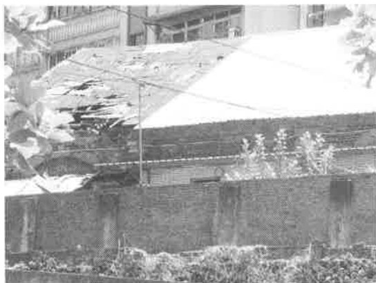
照片【3-4-107】禮堂北側屋頂損壞情形。
