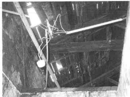
照片【3-4-106】屋頂破損處木構架嚴重腐朽。
