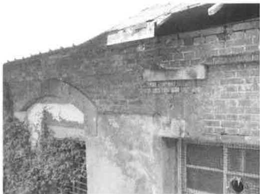
照片【3-4-101】禮堂東北側扶壁柱缺失情形。
