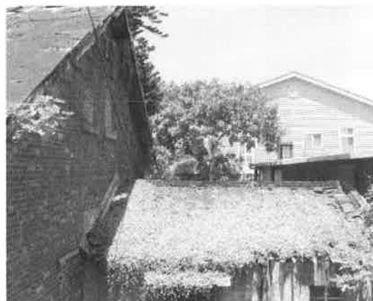
照片【3-3-14】 平房建築搭接於山牆面上，屋頂為閩南瓦形式。
