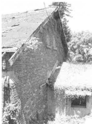
照片【3-4-103】北向立面外牆因增建而有水泥填補的痕跡。
