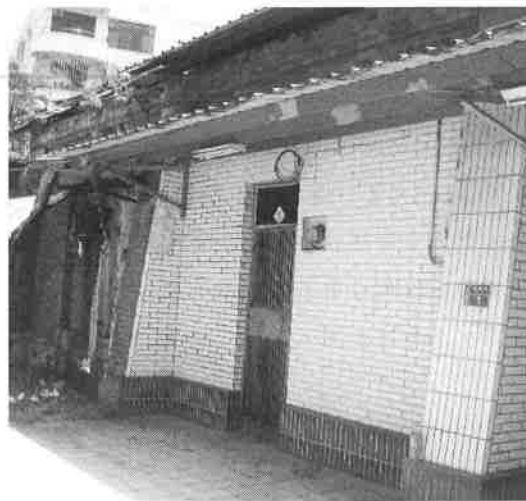
照片【3-3-7】 禮堂西向立面正中央無拱圈建造的痕跡。
