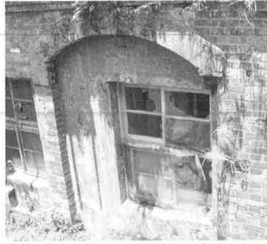
照片【3-3-9】 拱圈內現有開窗偏向一邊，為上下推拉窗。
