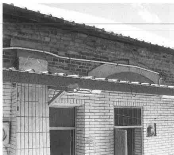
照片【3-3-6】 禮堂西南向的拱圈與扶壁柱柱頭皆為混凝土材料。
