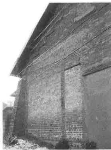
照片【3-4-104】南向立面外牆開口填補及白華現象。
