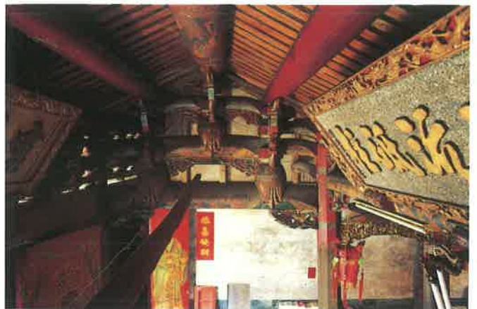
前殿棟架爲二通三瓜式，瓜筒風格屬泉派之木瓜形。
