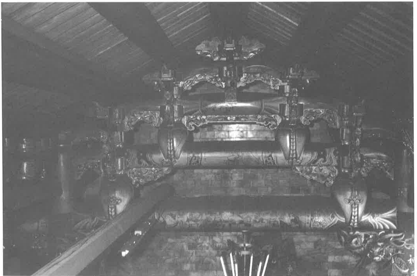
正殿架內棟架採「三通四瓜一騎枋拱」形式。
