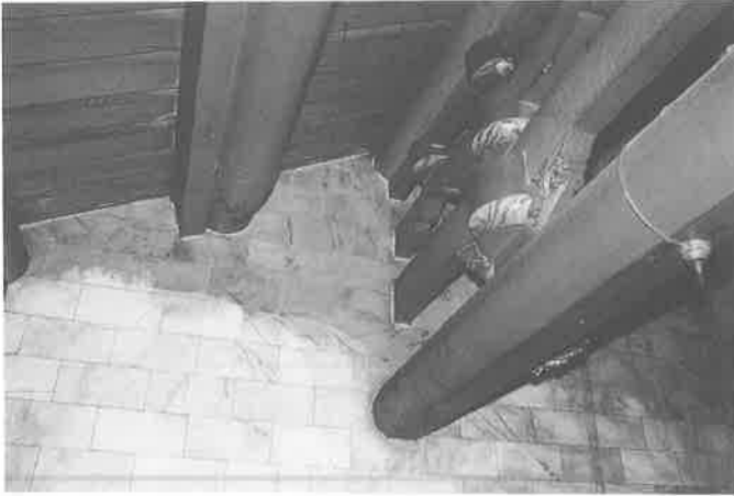
正殿內未做附壁棟架，而是將桁，桁引插入牆體。
