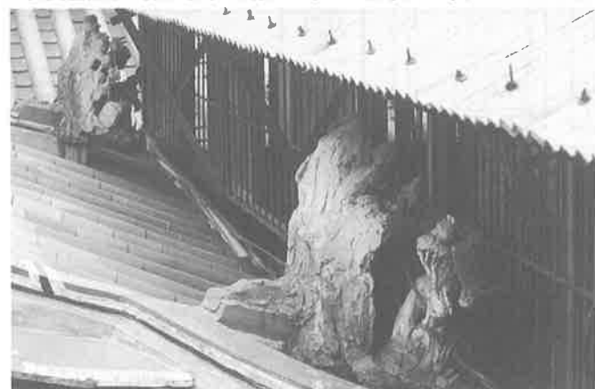
拜殿屋脊的牌頭因加蓋的石棉板而被破壞。
