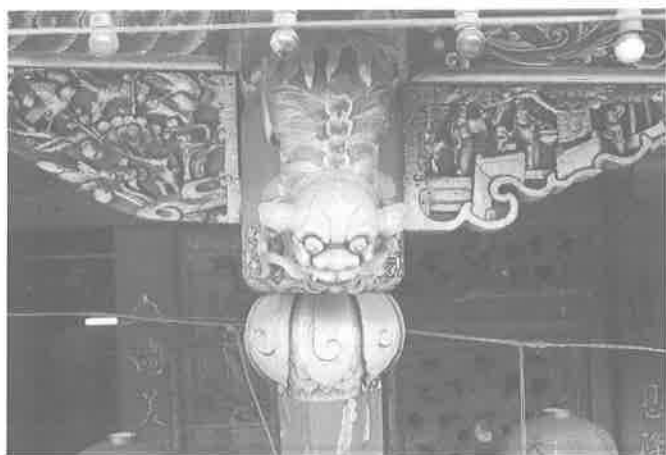
三川步口的豎柴雕成倒爬獅子，遮住接榫處。
