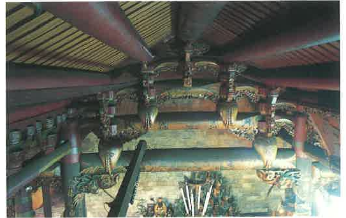
正殿之棟架採三通五瓜式，瓜筒為泉派之木瓜形。
