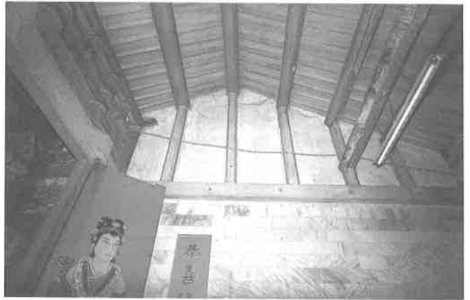
前殿釘上木樑以鞏固微傾木桁。
