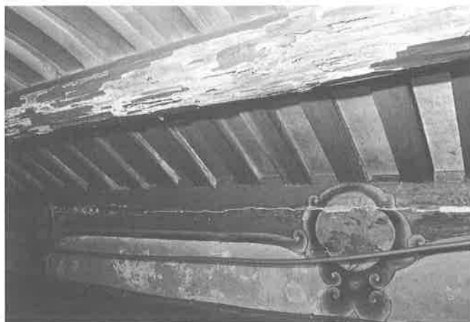
腐朽過度的木樑，可予以古法更換。
