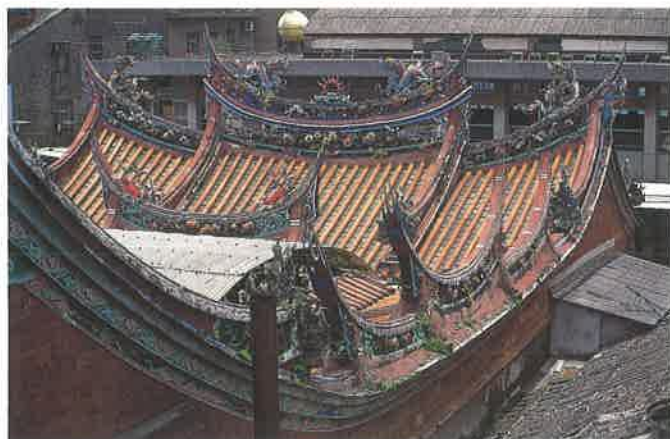
福佑宮西側山牆，簷口線從前殿經兩廊連接到正殿。
