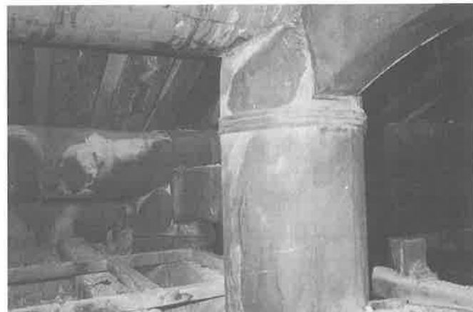
局部桁木須做防水、防蟲處理。
