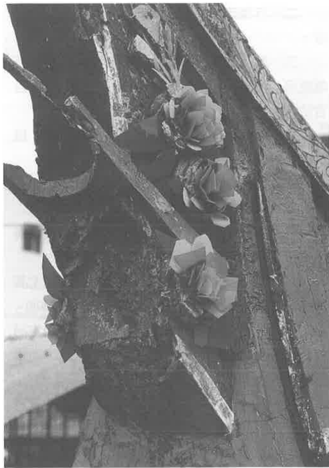
屋脊受損的部分檢視、校正後修護。
