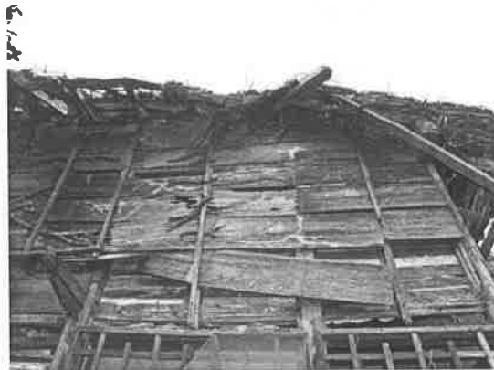
照片 4-1.34 押椽板材破壞
