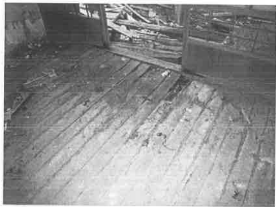
照片 4-1.93 腐朽破壞
