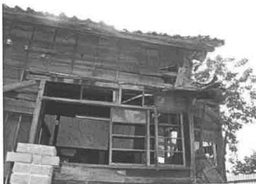
照片 4-1.32 板材乾裂變色
