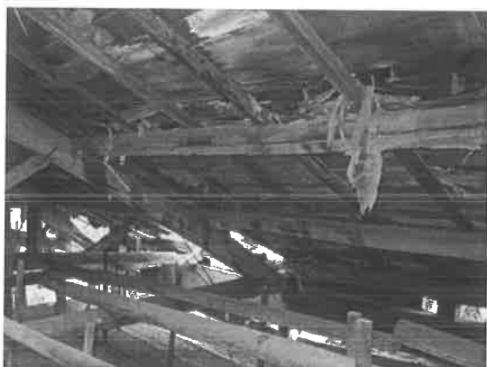
照片 4-1.83 母屋腐朽破壞
