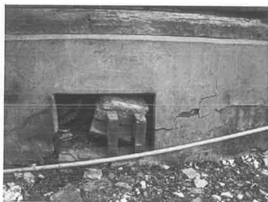
照片 4-1.28 磚格柵破壞
