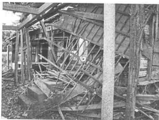
照片 4-1.113 天井崩落破壞
