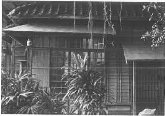
照片 3-3.8 多田榮吉故居及周邊其他日式宿舍之下見板板材較小，並有黑色木材節點
