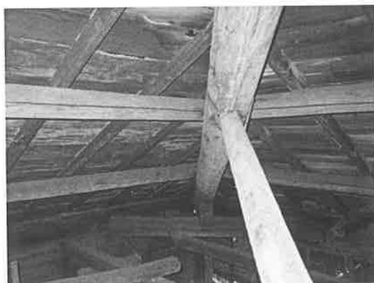
照片 4-1.82 母屋劈裂破壞
