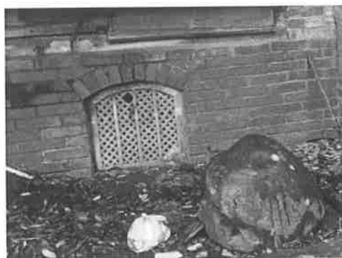
照片 3-3.11 高挑的拱型換氣孔（窗）
