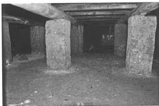
照片 3-3.12 床板下之足緣構造
