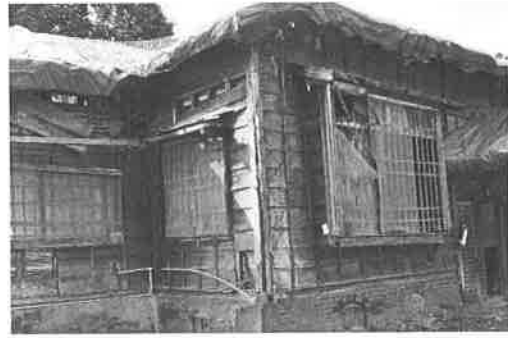
照片 3-3.5 自軒桁起一路鋪設至土臺之押椽式下見板外壁
