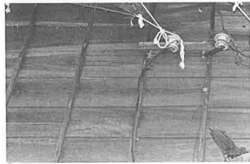
照片 3-3.7 尺寸較寬、紋理分明無節點破口的下見板板材
