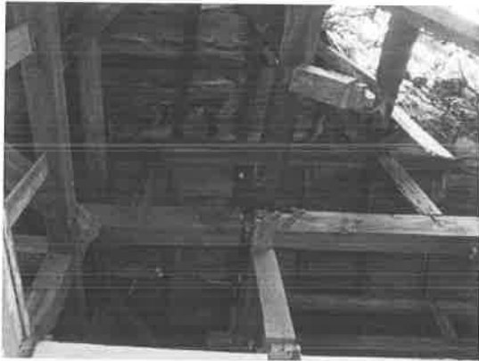
照片 4-1.75 木構件脫落
