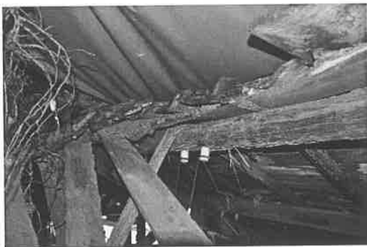
照片 3-3.18 屋面破損處尚未發見防水層
