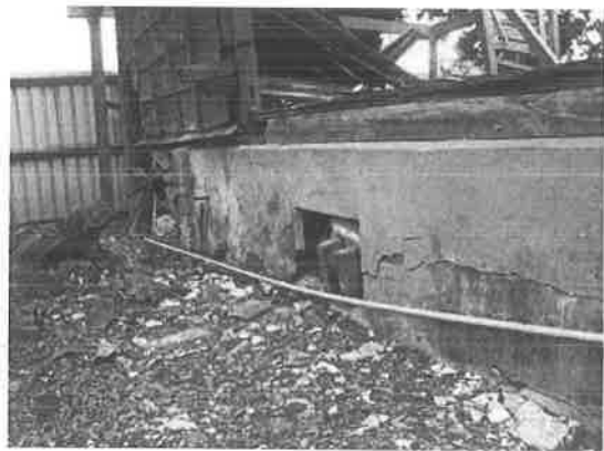
照片 4-1.22 水平裂縫
