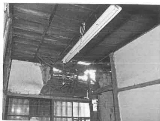
照片 4-1.110 變形下陷破壞
