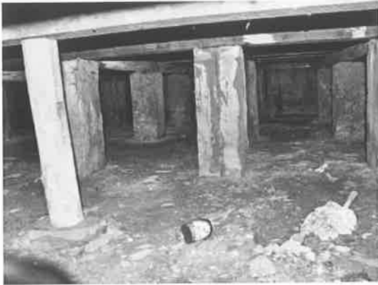
照片 4-1.7 防蟻混凝土
