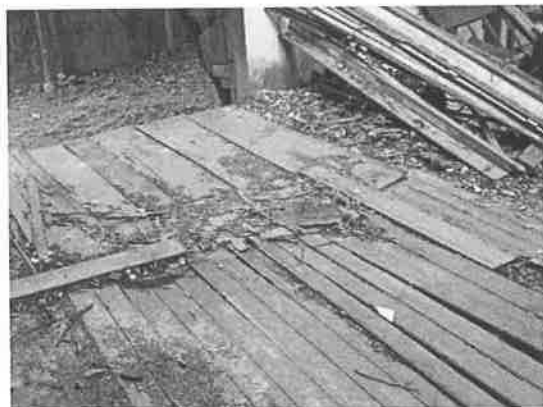
照片 4-1.62 床板破壞
