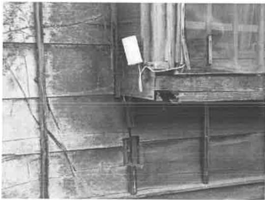
照片 4-1.129 窗作構件破壞
