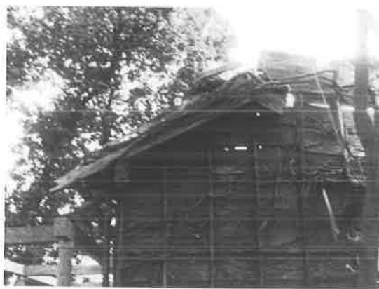
照片 4-1.52 鼻隱破壞
