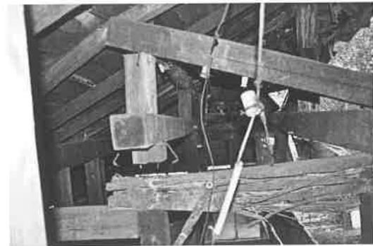
照片 3-4.12 座敷床間上方之和小屋屋架與屋架間的改建痕跡
