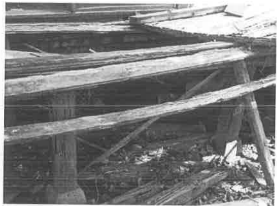
照片 4-1.56 構件腐朽坍塌
