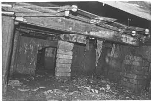
照片 3-4.11 建物西側腰基內部尚有一層磚砌腰基及通氣孔
