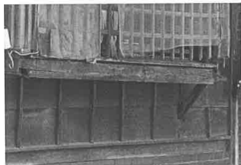
照片 3-3.6 每隔 40 公分一支的押椽，及下見板末梢之雨押
