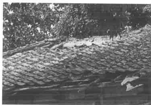
照片 3-3.2 屋面破損嚴重，部分瓦料均已不存
