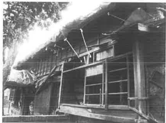
照片 4-1.130 窗作腐朽破壞
