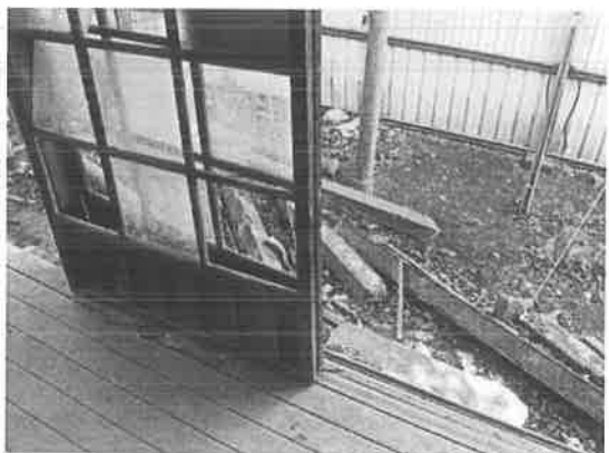
照片 4-1.124 緣側拉門破壞
