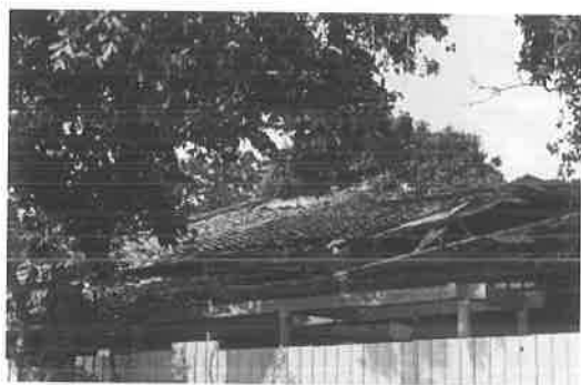
照片 3-3.1 配合空間延展而多處轉折、形狀複雜之寄棟式屋頂
