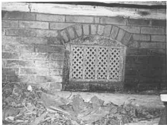
照片 4-1.24 平型換氣孔
