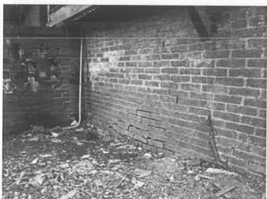
照片 4-1.40 磚體下陷破壞
