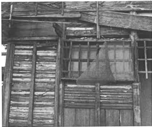
照片 3-4.9 建物右側空間均使用木摺壁下地作為牆面構造
