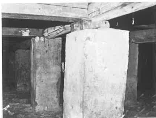
照片 4-1.61 構件變色乾裂
