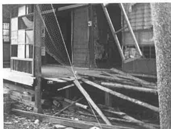
照片 4-1.63 構件腐朽
