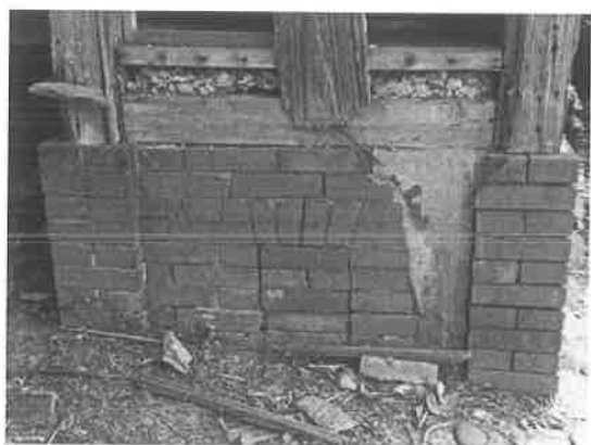
照片 4-1.27 換氣口封填
