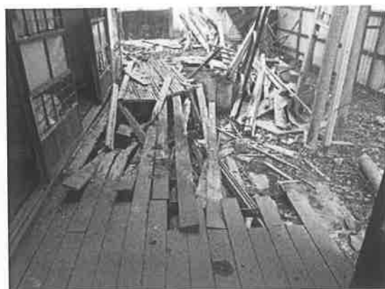
照片 4-1.64 床結構破壞
