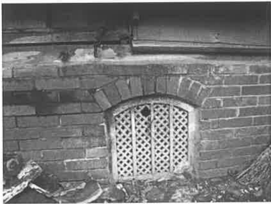
照片 4-1.23 弧型換氣孔
