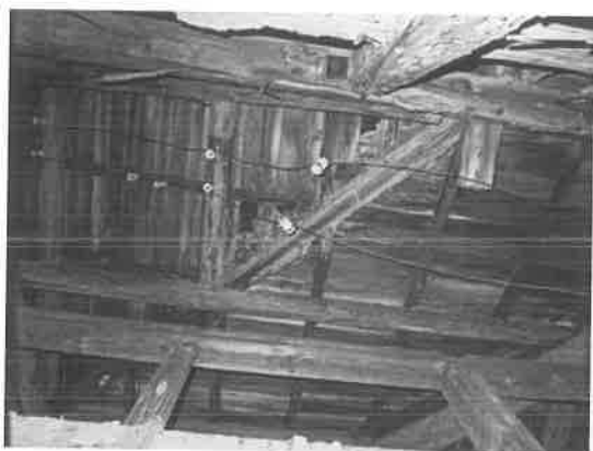
照片 4-1.47 構件腐朽
