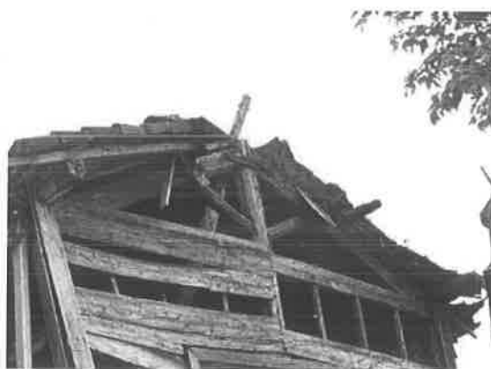
照片 4-1.86 屋架構件腐朽
