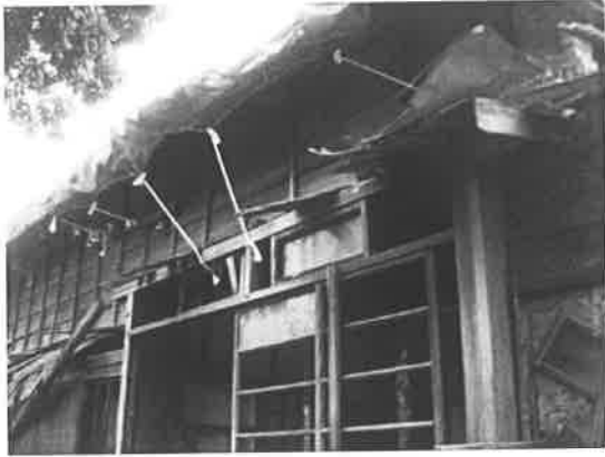
照片 4-1.133 構件腐朽破壞
