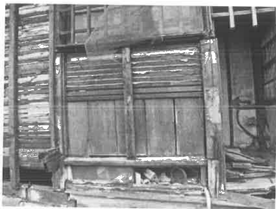
照片 4-1.101 牆體構造
