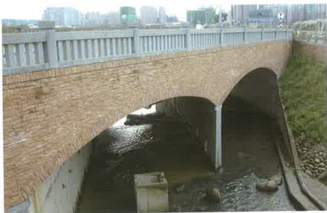
新建公司田溪橋下以門字形水泥樁保護橋墩石板出土地。
