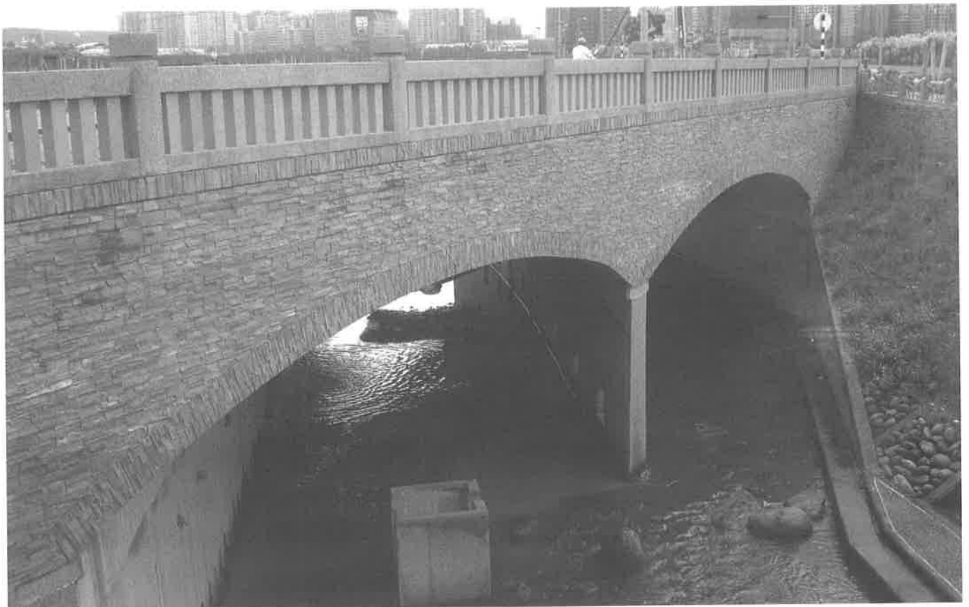
照片3- 11、公司田溪橋原有橋墩基石保護箱涵。
