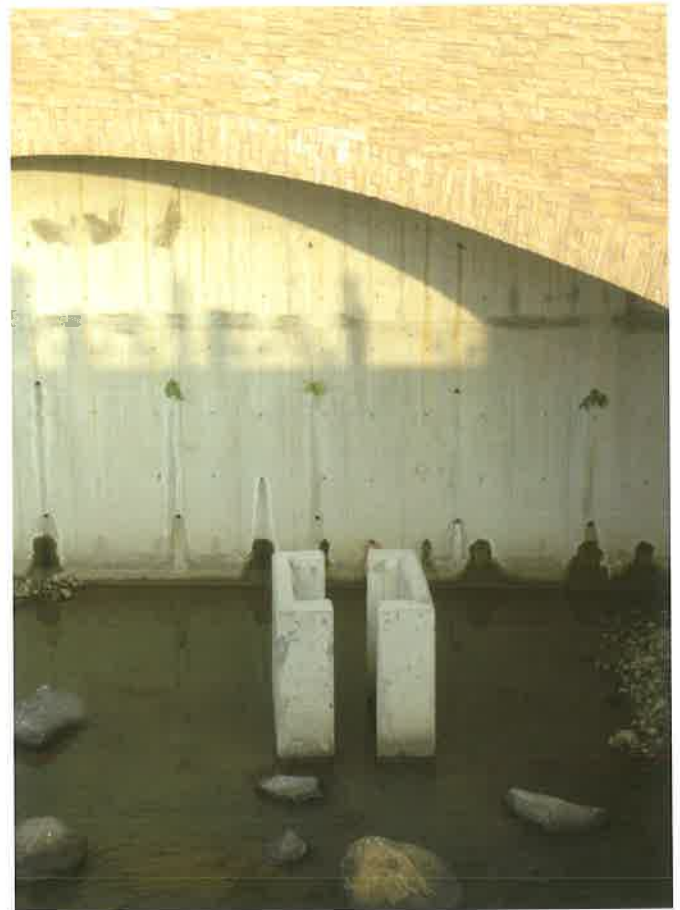
新建公司田溪橋下保護橋墩石板出土地之「」字形水泥樁。
