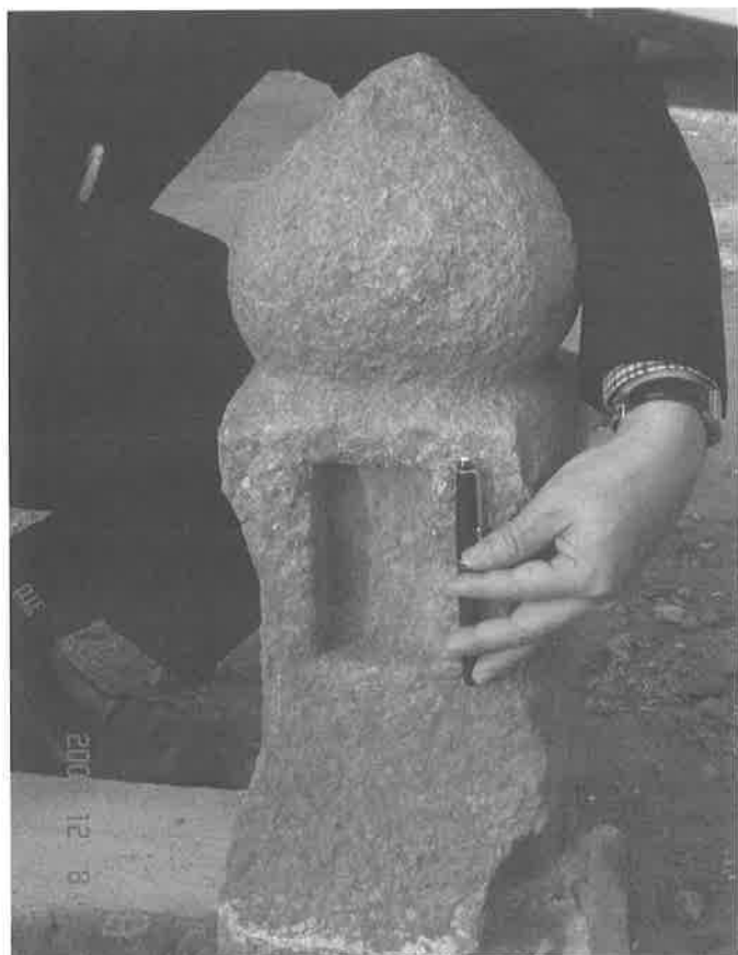
照片4- 6、公司田溪橋護欄立柱殘件。
