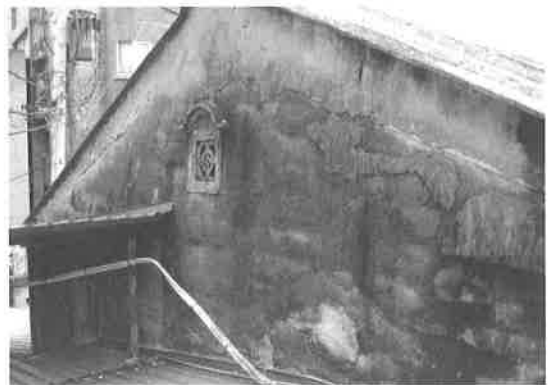
外牆水泥砂漿粉刷層剝落嚴重
