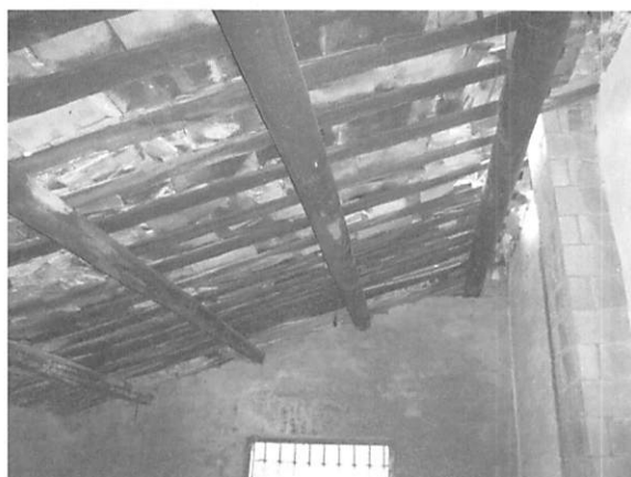
【圖5-2-27】灶腳(2)木構件水漬腐朽現象
