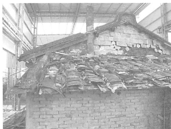
【圖 5-2-10】灶腳屋面損壞之情形
