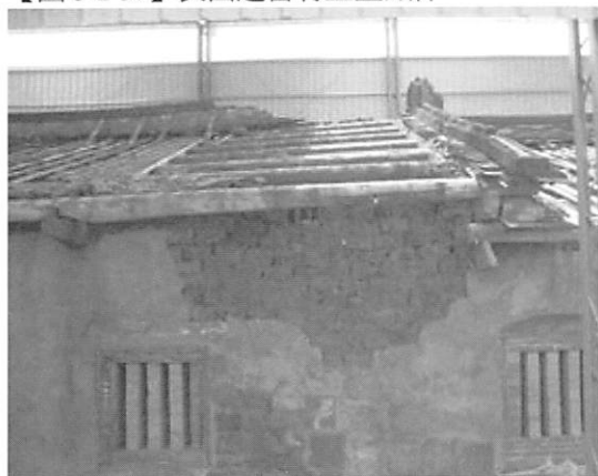
【圖 5-2-59】房間(1、3)牆面損壞情形
