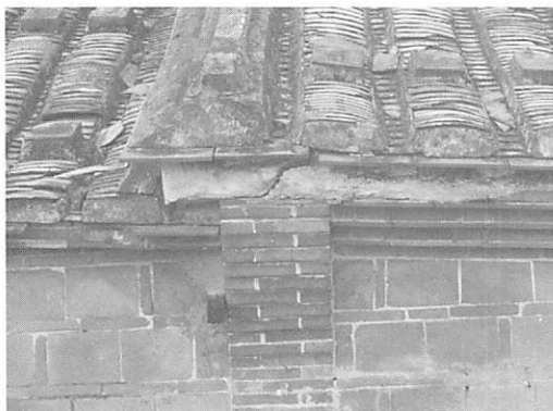
【圖 5-2-16】火庫起上方粉刷層龜裂
