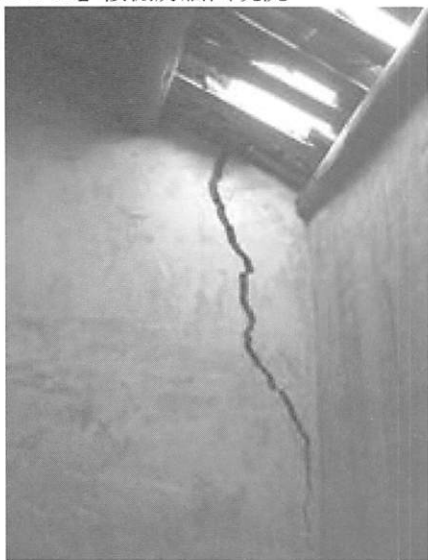
【圖 5-2-65】房間(1)牆體損壞現象
