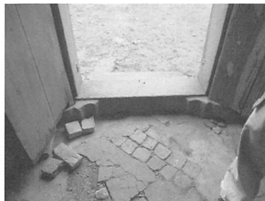
【圖 4-3-20】原有地磚破損後以紅磚代替
