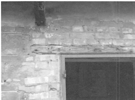
【圖 5-2-77】斗子砌牆面損壞情形
