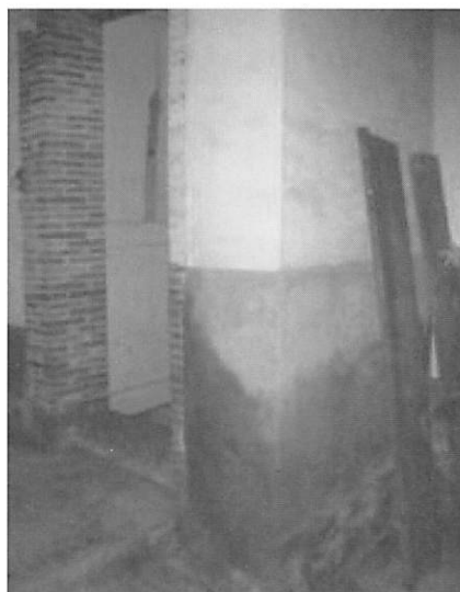
【圖 5-2-75】底部卵石砌以用水泥沙將粉光抹平
