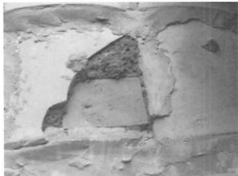
【圖 5-2-73】山牆之穿瓦衫部分瓦片已掉落
