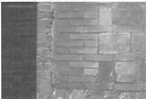
【圖 5-2-69】外部牆面以紅磚補砌
