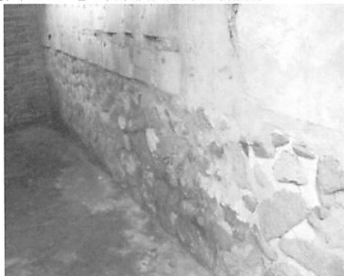
【圖 5-2-71】牆基卵石砌牆基受到侵蝕、流失
