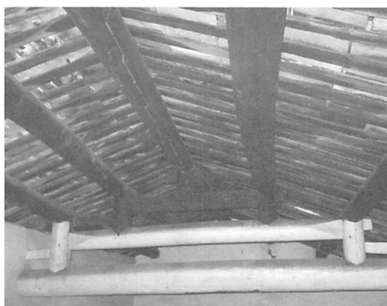
【圖5-2-28】飯廳空間中脊桁縱向裂縫損壞
