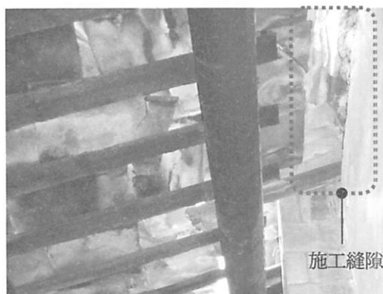
【圖 5-2-9】灶腳(2)椽條及望磚的水漬腐朽現象
