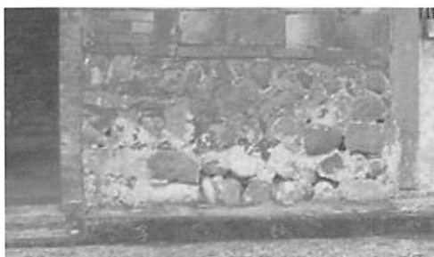
【圖 5-2-68】牆基損壞現象
