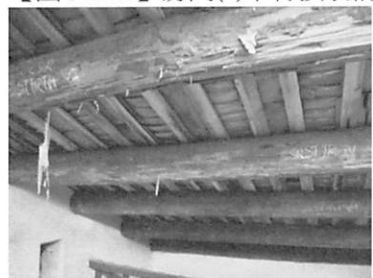
【圖 5-2-24】房間(3)木材損壞情況
