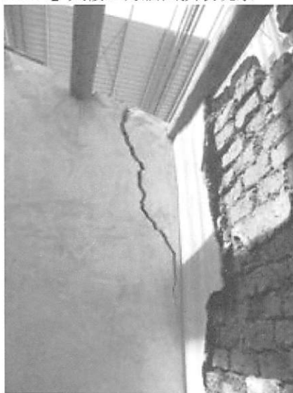
【圖 5-2-66】房間(1)牆面損壞現象
