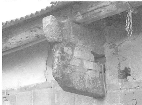
【圖 5-2-19】左護龍出挑加高的損壞情況
