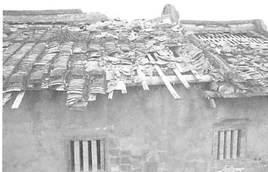
【圖 5-2-4】正身後側屋面破壞
