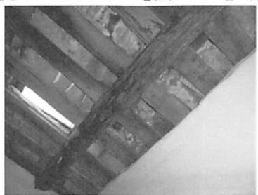
【圖 5-2-25】木構件腐朽現象
