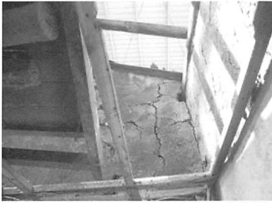
【圖 5-2-67】房間(3)天花本頂部牆面損壞現象
