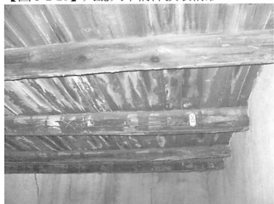
【圖 5-2-22】房間(1)木材損壞情況
