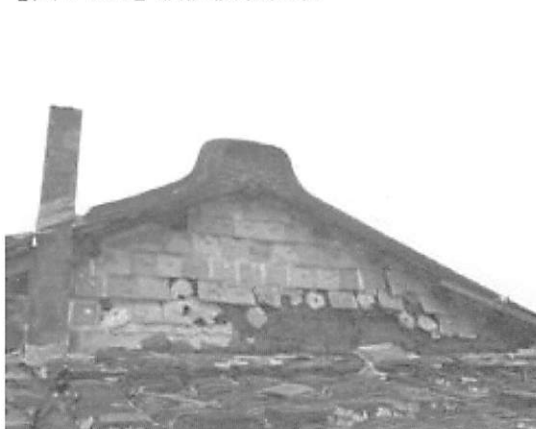
【圖 5-2-60】右側山牆穿瓦衫部分瓦片掉落
