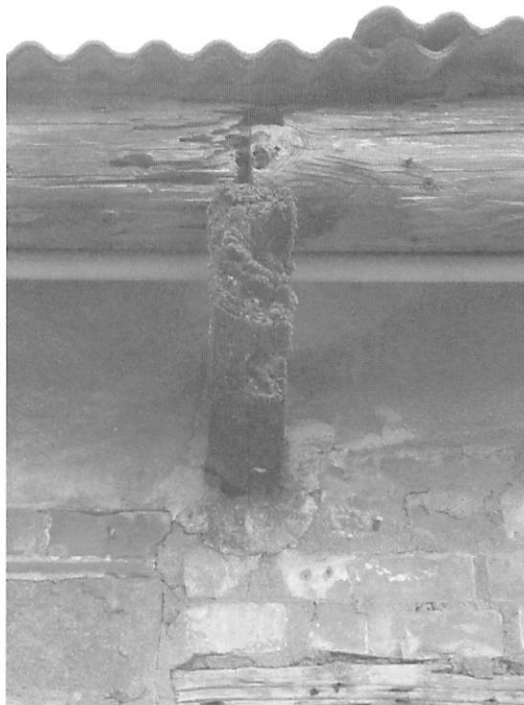
【圖5-2-33】出檐檁樑構件損壞現象
