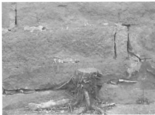
【圖 5-2-56】牆基腳有植栽附生的情形
