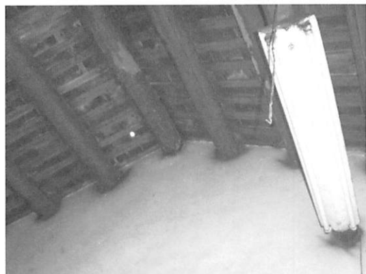
【圖 5-2-20】大廳大木構件損壞情形
