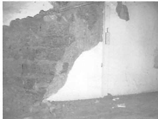
【圖 5-2-64】夾樓上方牆面損壞現象
