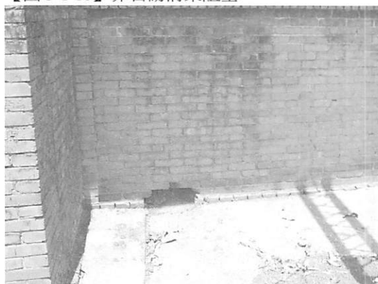
【圖 5-1-12】排水明溝損壞之情形
