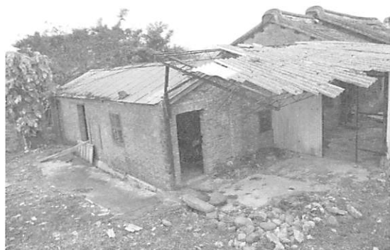
【圖 5-2-14】原有屋瓦已更換成石綿瓦屋頂
