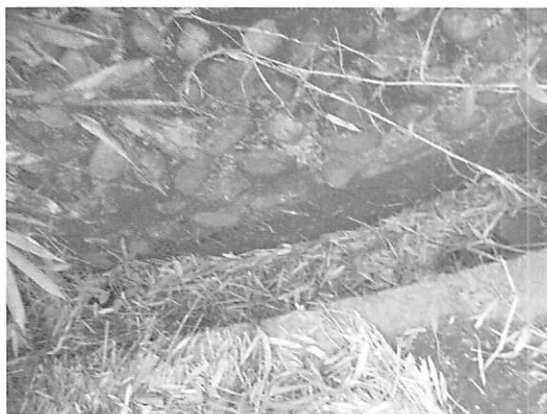
【圖 5-1-10】卵石砌溝渠阻塞
