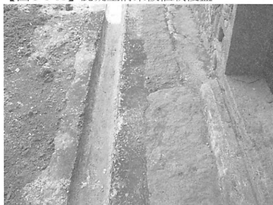
【圖 5-1-13】右護龍犬走損壞之情形
