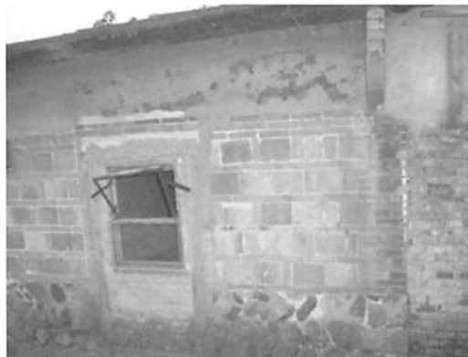
【圖 5-2-78】正立面牆面損壞情形情形
