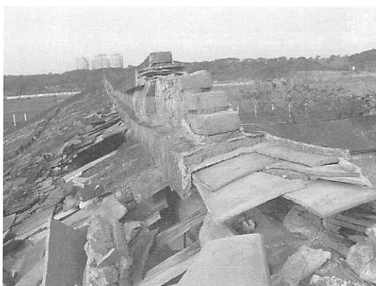
【圖 5-2-3】屋脊斷裂損壞之情況
